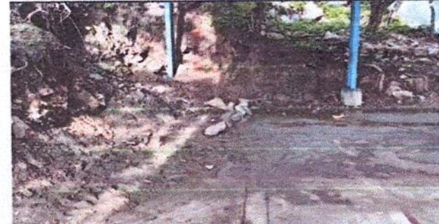
Instalacion de cuneta de concreto.
