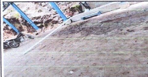
Foto 5: Levantamiento de 3 hiladas de block con repello y cernido para aerea de cancha de jurgo. Esto evitara que el agua ingrese ala cancha de juegos, ya que es la entrada principal al establecimiento educativo.
