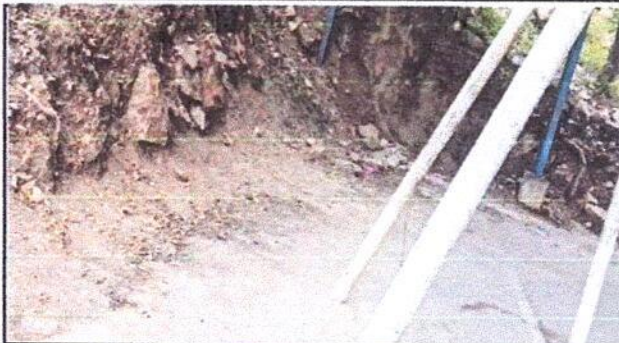
Instalación de cuneta de concreto en el area afectada, ayudara a que el agua pueda salir para mantener el ingreso del establecimiento limpio y seco para que los estudiantes no corran riesgo de deslizarse y prevenir
