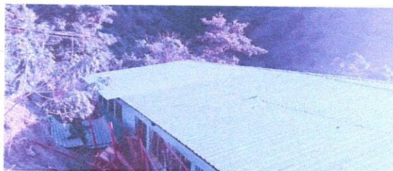
Foto 4: SUSTITUCION DE LAMINA TROQUEADA ALUZINC CALIBRE 26 EN AULA 3.
