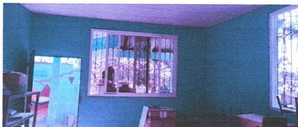
Foto 1: INSTALACION DE 2 VENTANAS DE PVC DE 2 MTS DE ANCHO X 1.55 ALTO, EN AULA 1
