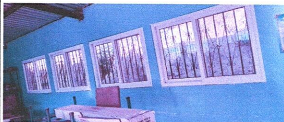
Foto 2: INSTALACION DE 10 VENTANAS DE PVC DE 1.40 MTS DE ANCHO X 1.40 ALTO, EN AULA 2.
