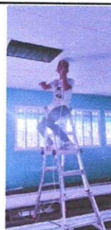
Foto 10: REPARACION DE CABLEADO ELECTRICO.
