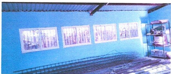
Foto 3: INSTALACION DE 4 VENTANAS DE PVC DE 1.42 MTS DE ANCHO POR 1.00 DE ALTO, EN AULA 3.
