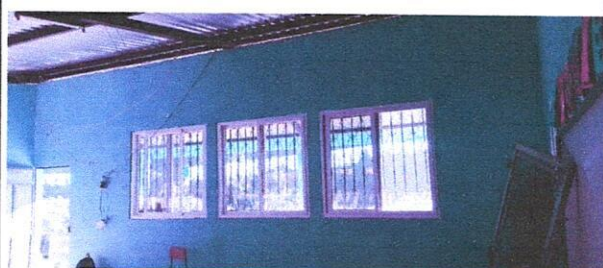
Foto 3: INSTALACION DE 4 VENTANAS DE PVC DE 1.42 MTS DE ANCHO POR 1.00 DE ALTO, EN AULA 3.
