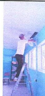
Foto 12: INSTALACION DE CIELO FALSO DE PVC EN AULAS.
