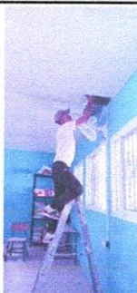
Foto 13 :INSTALACION DE CIELO FALSO DE PVC EN AULAS.
