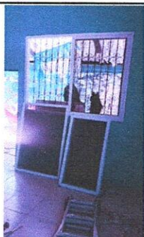
Foto 1: INSTALACION DE 2 VENTANAS DE PVC DE 2 MTS DE ANCHO X 1.55 ALTO, EN AULA 1
