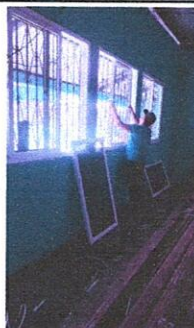
Foto 2: INSTALACION DE 10 VENTANAS DE PVC DE 1.40 MTS DE ANCHO X 1.40 ALTO, EN AULA 2.
