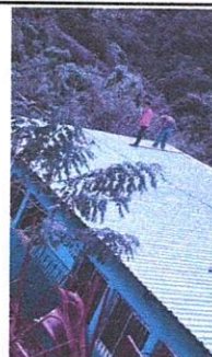
Foto 4: SUSTITUCION DE LAMINA POR LAMINA TROQUEADA ALUZINC CALIBRE 26 EN AULA 3.
