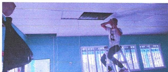
Foto 07 : SUSTITUCION DE PLAFONERAS
