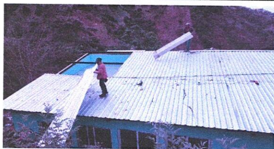
Foto 5: SUSTITUCION DE CANAL DE METAL EN AULA 3.
