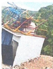
Foto 7: IMPERMEABILIZACIÓN DE LOSA .
