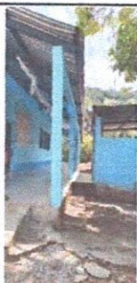
Foto 9: SUSTITUCION DE CANAL DE METAL .
