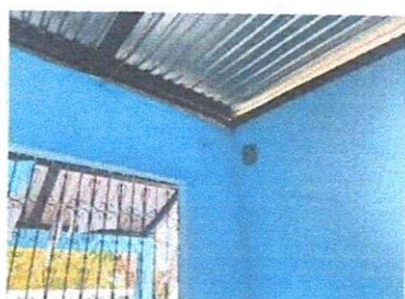
Foto 15: REPARACION DE CABLEADO ELECTRICO.
