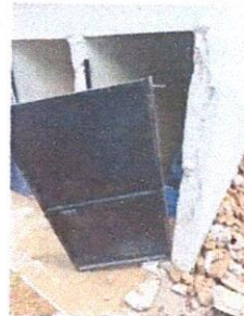
Foto 6: MANTENIMIENTO DE ESTRUCTURA EN PUERTA DE BAÑO DE 0.85 MTS DE ANCHO X 1.48 DE ALTO (LIJADO, CAMBIO DE TUBO, CEPILLADO).
