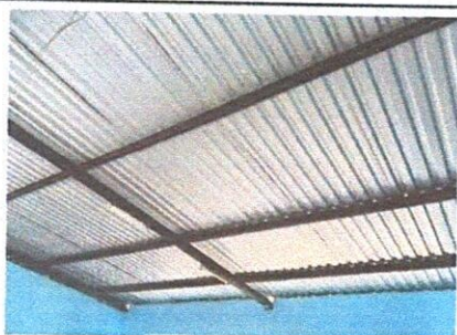
Foto 17: INSTALACION DE CIELO FALSO DE PVC EN AULAS.
