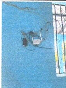
Foto 13: SUSTITUCION DE TOMACORRIENTE DOBLE.
