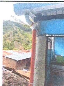
Foto 10: SUSTITUCION DE BAJADA DE AGUA PLUVIAL POR TUBO PVC DE 3" .
