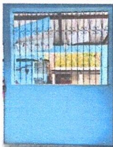
Foto 1: INSTALACION DE 2 VENTANAS DE PVC DE 2 MTS DE ANCHO X 1.55 ALTO, EN AULA 1
