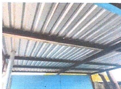
Foto 4: SUSTITUCION DE LAMINA POR LAMINA TROQUEADA ALUZINC CALIBRE 26 EN COCINA.
