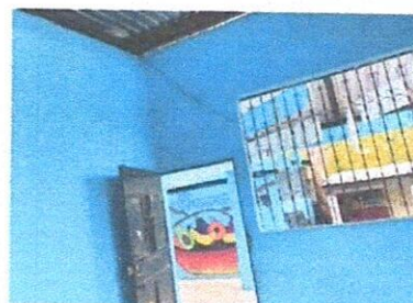
Foto 16: SUSTITUCION DE DUCTO ELECTRICO + ACCESORIOS.
