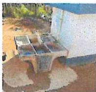
Foto 3: Baños: Instalación de puertas, sustitución de pilas, instalación de torta de concreto para pilas, instalación de piso cerámico, instalación de inodoros.
