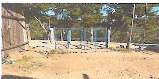
Foto 5: Entrada principal: Aplicación de torta de concreto, sustitución de porton, sustitución de pilares.
