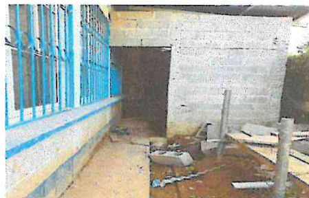
Foto 2: Cocina: Instalación de base para tinaco, instalación de tinaco e instalación de puerta.
