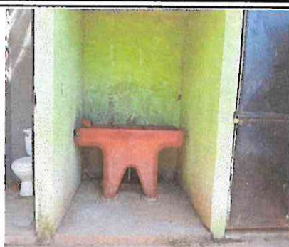
Foto 2: Sustitución de pila plástica de dos lavadores.
