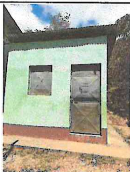
Foto1: Reparación de cocina.
