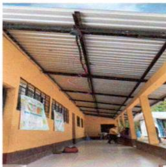
Foto 13: Instalación de cableado electrico calibre 12 fase
