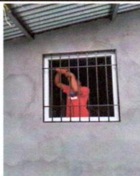
Foto 5: Suministro e instalación de Balcón de metal
