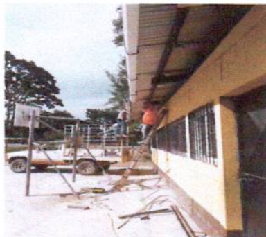
Foto 11: Suministro e instalación de canal de PVC en aula 2
