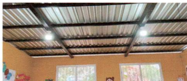
Foto 18: Instalación de Plafoneras
