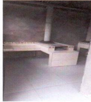
Foto 2: Sustitución de piso de cemento por piso ceramico en cocina
