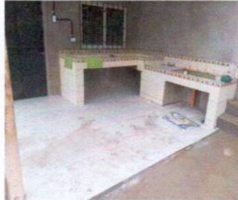
Foto1: Aplicación de repello en paredes de cocina exterior e interior
