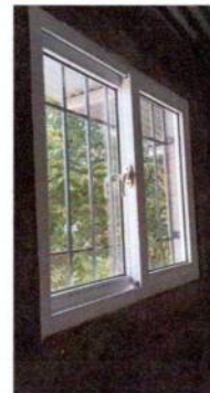
Foto 4: Suministro e instalación de ventana PVC
