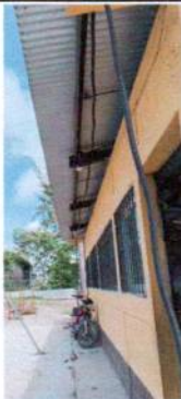
Foto 21: Instalación de Flexitubo
