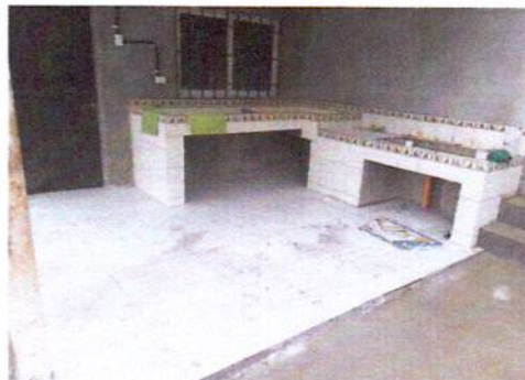
Foto 8: Suministro e instalación de azulejo en pila y base de cemento en cocina
