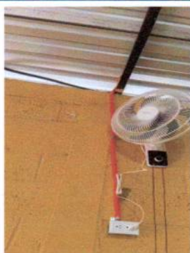
Foto 15: Instalación de tomacorriente doble
