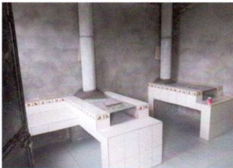
Foto 3: Suministro e instalación de estufa rural (completa) Base, chimenea y plancha de metal
