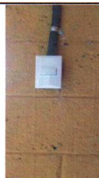
Foto 16: Instalación de apagador simple
