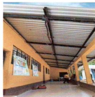
Foto 14: Instalación de cableado electrico calibre 12 Neutro
