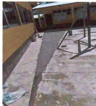
Foto 12: Sustitución de piso de tierra por torta de cemento frente a aula 2
