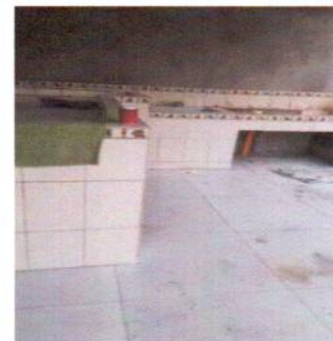
Foto 6: Suministro e instalación de tablón de cemento ancho 0.50* 0.90 de alto * 2.5 de largo
