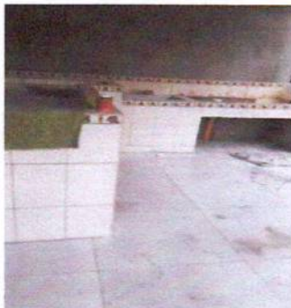
Foto 7: Suministro e instalación de azulejo en tablán de cemento
