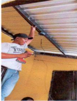
Foto 19: Instalación de cajas octagonales
