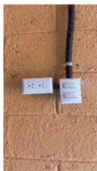
Foto 17: Instalación de apagador doble
