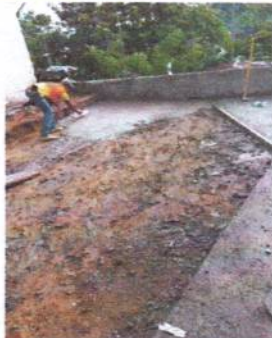
Foto 9:Sustitución de piso de tierra por entortado de cemento frente de cocina y parte de atrás.
