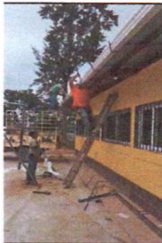
Foto 11:Suministro e instalación de canal de PVC en aula 2
