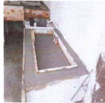
Foto 8: Suministro e instalación de azulejo en pila y base de cemento en cocina
