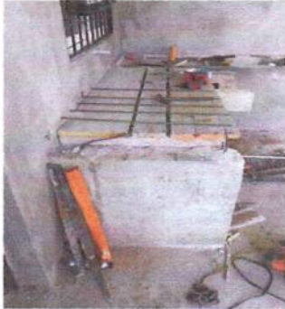
Foto7:Suministro e instalación de azulejo en tablón de cemento
