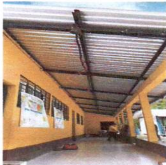
Foto 13: Instalación de cableado electrico calibre 12 fase
