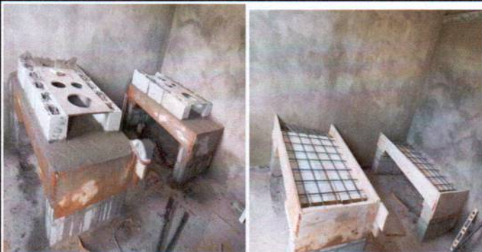
Foto 3: Suministro e instalación de estufa rural (completa) Base, chimenea y plancha de metal
