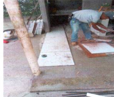
Foto 2: Sustitución de piso de cemento por piso ceramico en cocina
