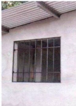
Foto 5: Suministro e instalación de Balcón de metal
