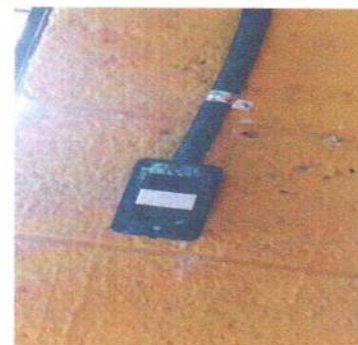
Foto 16: Instalación de apagador simple
