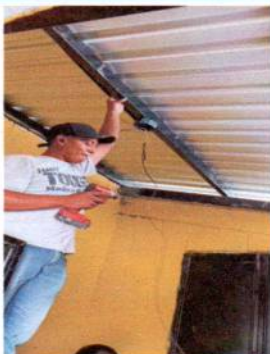
Foto 19: Instalación de cajas octagonales
