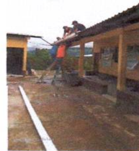
Foto 10:Suministro e instalación de canal PVC en aula 1
