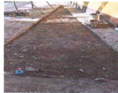
Foto 12:Sustitución de piso de tierra por torta de cemento frente a aula 2
