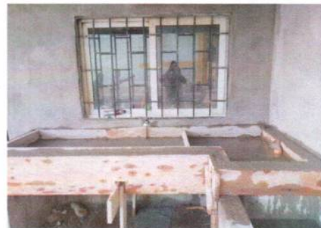
Foto 6: Suministro e instalación de tablón de cemento ancho 0.50* 0.90 de alto * 2.5 de largo
