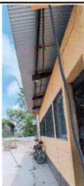
Foto 21: Instalación de Flexitubo
