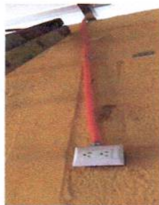
Foto 15: Instalación de tomacorriente doble
