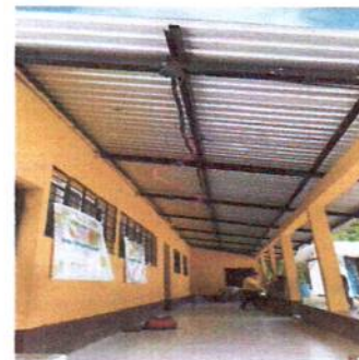
Foto 14: Instalación de cableado electrico calibre 12 Neutro
