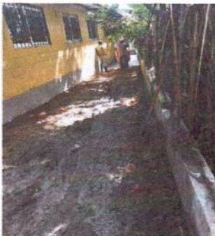
Foto 9:Sustitución de piso de tierra por entortado de cemento frente de cocina y parte de atrás.
