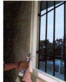
Foto 4: Suministro e instalación de ventana PVC
