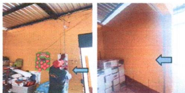
Foto 20: Instalación de cajas rectangulares
