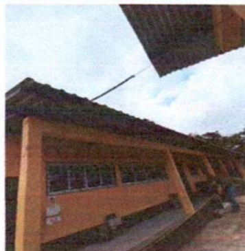
Foto 10: Suministro e instalación de canal PVC en aula 1
