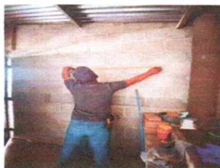
Foto 4: Suministro e instalación de ventana PVC
