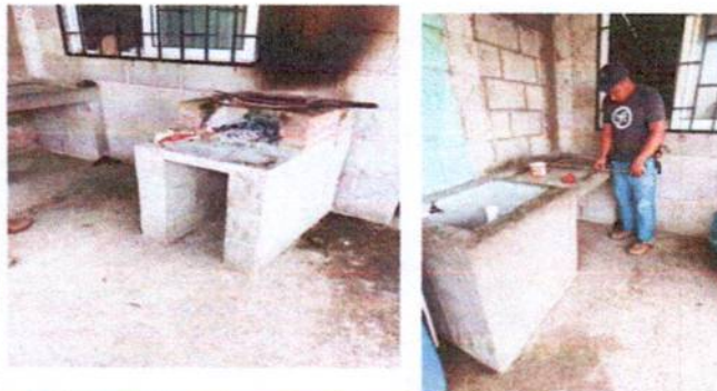
Foto 8: Suministro e instalación de azulejo en pila y base de cemento en cocina
