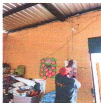
Foto 16: Instalación de apagador simple
