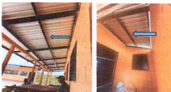
Foto 21: Instalación de Flexitubo
