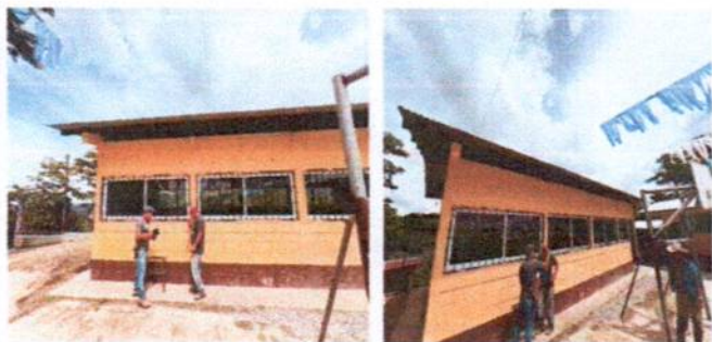
Foto 11: Suministro e instalación de canal de PVC en aula 2
