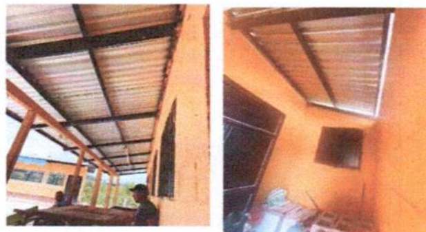
Foto 14: Instalación de cableado eléctrico calibre 12 Neutro
