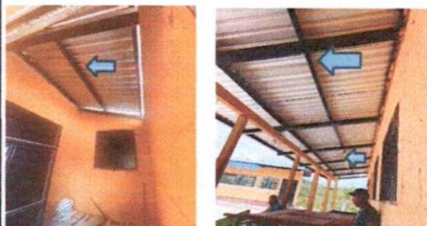
Foto 18: Instalación de Plafoneras
