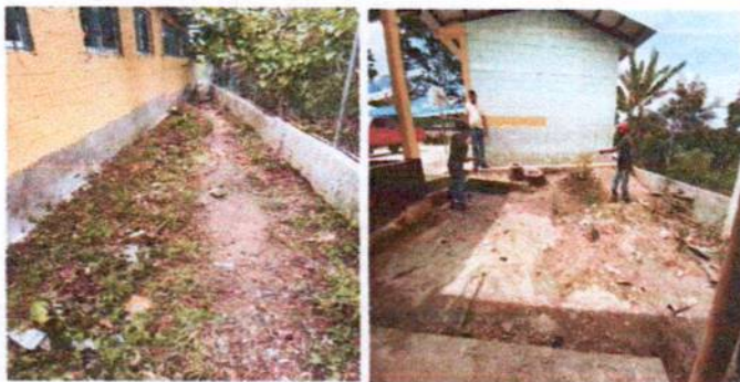
Foto 9: Sustitución de piso de tierra por entortado de cemento frente de cocina y parte de atrás.
