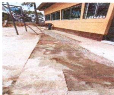
Foto 12: Sustitución de piso de tierra por torta de cemento frente a aula 2
