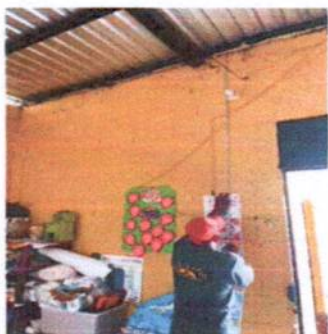
Foto 15: Instalación de tomacorriente doble
