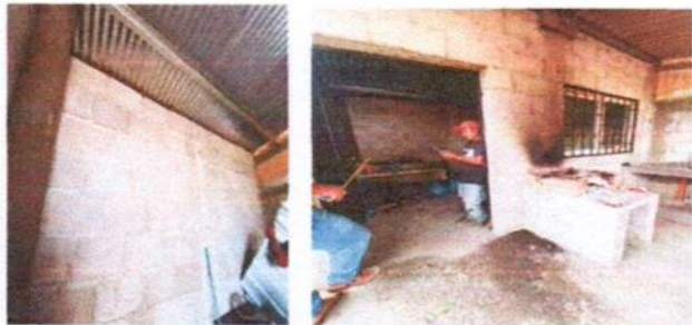
Foto1: Aplicación de repello en paredes de cocina exterior e interior
