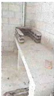
2.3: Instalación de azulejo en plancha de cemento
