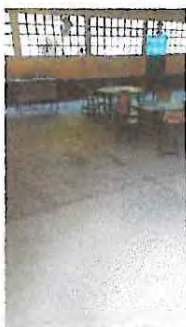
1.3: Sustitución de piso de cemento por piso cerámico
