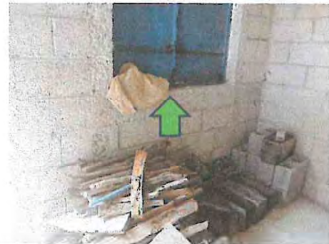
2.10: Instalacion de balcon en ventana
