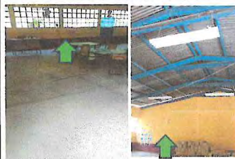
1.8: Instalación de toma de corrientes
