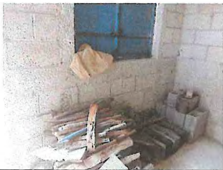
1.1: Sustitución de ventana de metal por ventana de PVC
