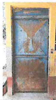
1.2 Sustitución de puerta de metal en mal estado por puerta de meta
