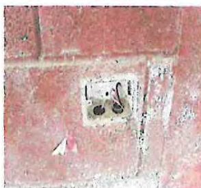
1.5: Instalación de cajas rectangulares
