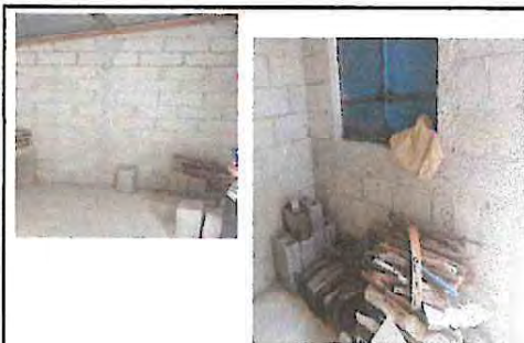
2.7: Aplicación de repello
