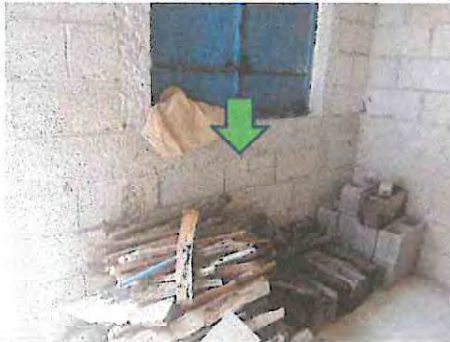
2.9: Instalacion de pilas de cemento de dos lavadores
