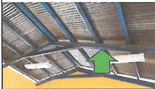
1.7: Instalación de plafoneras
