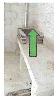
2.4: Instalación de carrizos o chimenea de cemento en plancha
