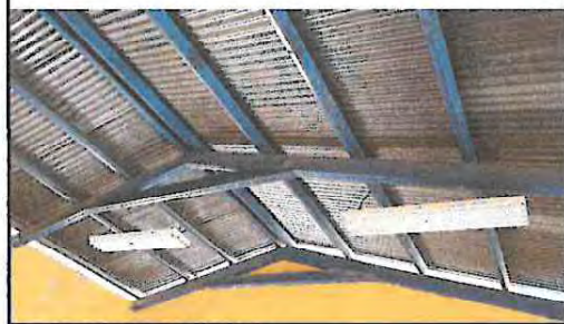
1.9: Instalación de Flexitubo
