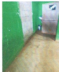
Foto 2: REPARACION DE PUERTA METÁLICA
