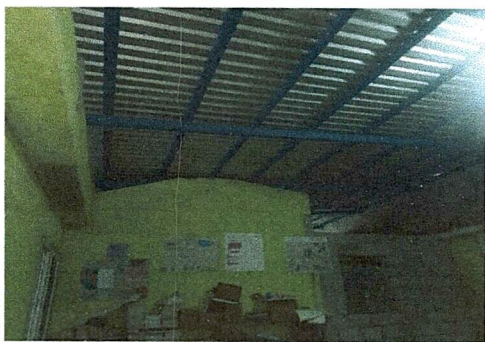
APLICACIÓN DE PINTURA EN PAREDES (PARTE INTERIOR)
