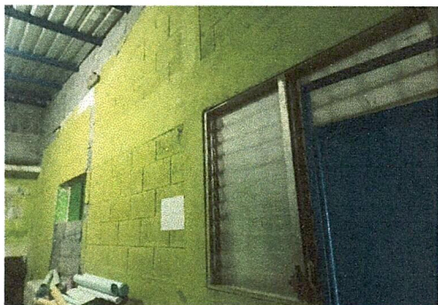
Foto 6: APLICACIÓN DE PINTURA EN PAREDES (PARTE INTERIOR)
