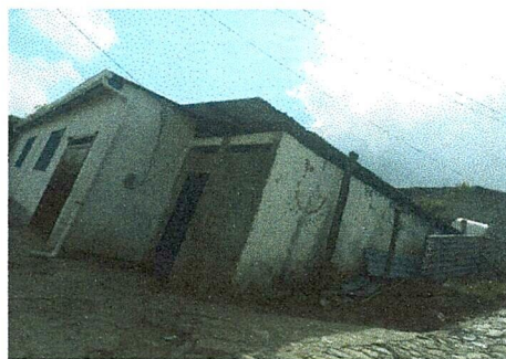
Foto 9: APLICACIÓN DE PINTURA EN PAREDES (PATE EXTERIOR)
