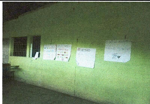
Foto 7: APLICACIÓN DE PINTURA EN PAREDES (PARTE INTERIOR)
