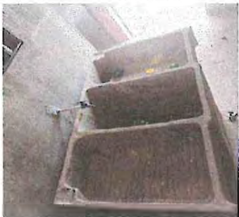
2.3 Instalación de pila de cemento en area de cocina de 1.30 x 0.90 un lavador
