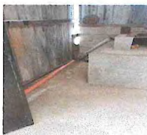
2.1 finalización de muro existente
