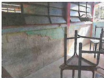
1.3: Aplicación de repello
