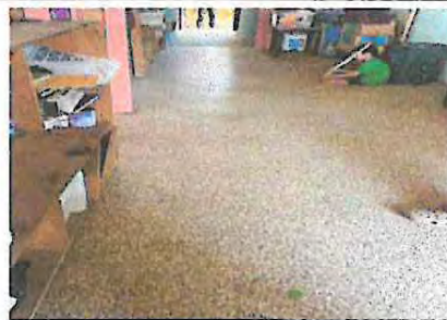
1.2 Sustitución de piso de cemento por piso cerámico
