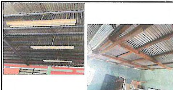
1.4: Instalación de lamparas led 100 watts de alta potencia
