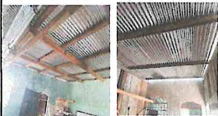
3.1 Instalación de cableado electrico
