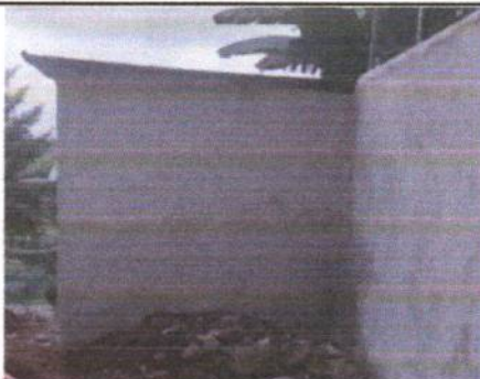
Muro Perimetral mioramiento en repello
