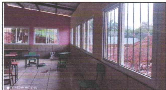
foto 2.7 mantninito a balcones limpieza y pintura
