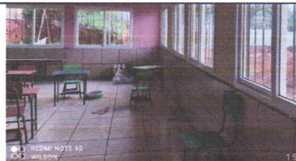
2.4 INSTALAR AZULEJO EN PAREDES.
