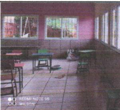
Foto 2 aula 2.1: iinstalar ceramico con adhecibo piso sobre piso.
