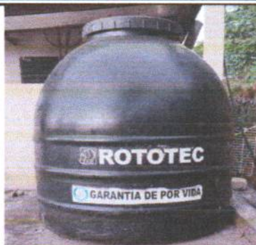
Foto2: 1.1 sustitución de de tinaco 1,100mts por tinaco de11,100mts y suministros
