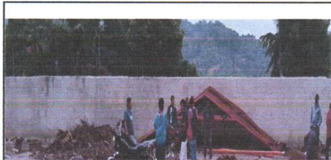
Muro perimetral, mejoramiento en muro cernido
