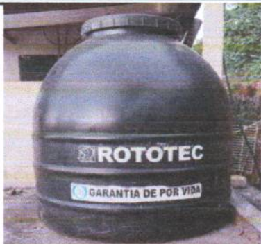
Foto1: 1.1 sustitución de de tinaco 1,100mts por tinaco de11,100mts y suministros
