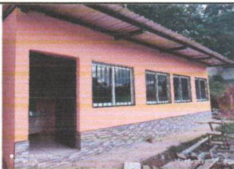
2.3 INSTALAR FACHALETA EXTERIOR.
