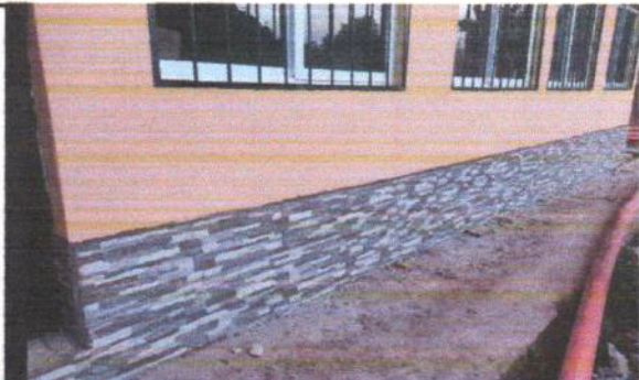
2.3 Instalación de fachaletas en pared exterior para evitar humedad.
