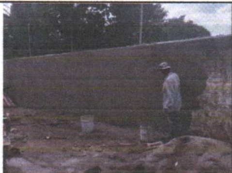
foto 6. 1 Muro perimetral 6.1 mejoramiento en repello en muro
