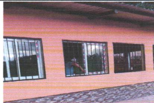
Foto 2.2 instalar ventanas corredizas PVC
