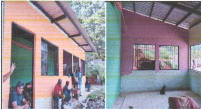
2.5 pintura en muros exteriores e interiores
