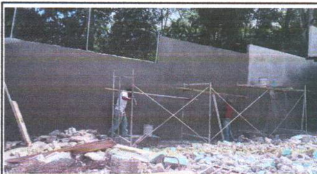
Foto 6.2. mejoramiento con cernido en muros
