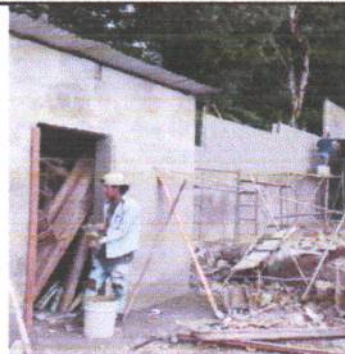
Foto 2.8 mantenimiento a puerta limpieza y pintura
