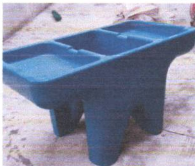
Foto 4.6 sustrucción de pila de concreto por pila plastica esta muy deteriorada
