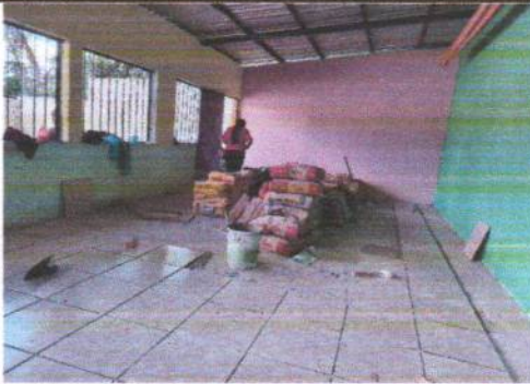
Foto 2 aula 2.1: instalar piso ceramico con adhesivo piso sobre piso.
