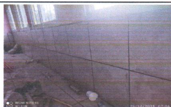
2.4 Instalación de azulejos en interior de aula para mayor durabilidad de la pared.
