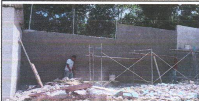
foto 6. 1 Muro perimetral 6.1 mejoramiento en repello en muro
