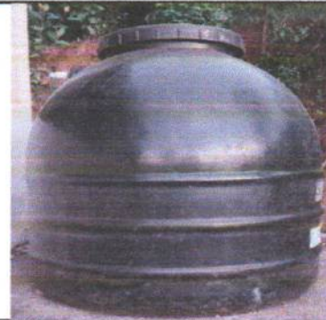
Foto 1. 1.1 .S ustitución de de tinaco 1,000lts por tinaco de 1,100lts accesorios y suministros
