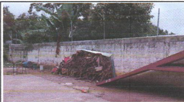
Foto 6.2. mejoramiento con cernido en muros
