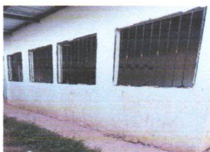
foto 2.7 mantninito a balcones limpia y pintura
