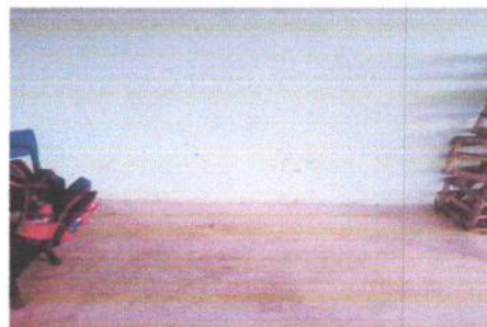
2.4 Instalación de azulejo en interior de aula.
