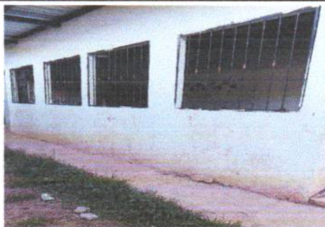
2.5 pintura en muros exteriores e interiores
