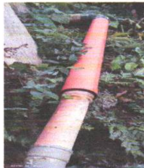
foto 5. Drenaje 5.1 Instalacion de tuberia para drenaje el que esta presta deteriorado
