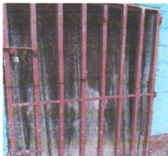
Foto 2.8 mantenimiento a puerta limpieza y pintura
