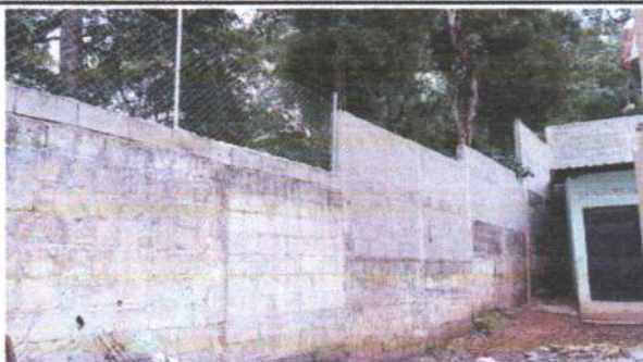
foto 6. 1 Muro perimetral 6.1 mejoramiento en repello en muro
