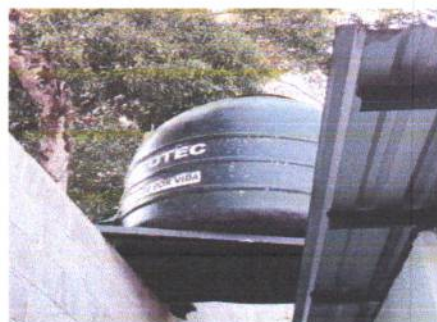
Foto1: 1.1 sustitución de tinaco 1,000Lts por tinaco de 1,100lts y suministros
