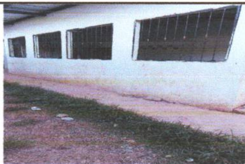
2.3 Instalación de fachaleta en pared exterior.
