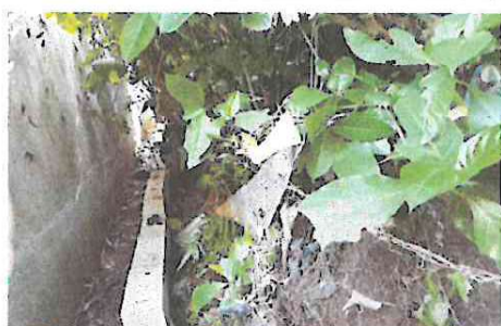
Foto 3: mejoramiento de Muro Perimetral
