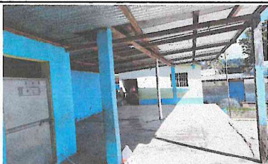
Foto1: Mejoramiento de techo
