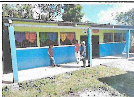
Foto 2: Instalación de ventanas de corredizas de pvc
