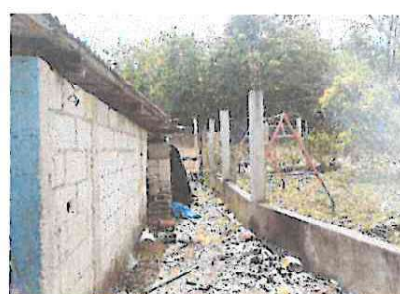
Foto 6: sustitución de porton con maya de agujero
