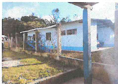
Foto 4: cercado de muro perimetral
