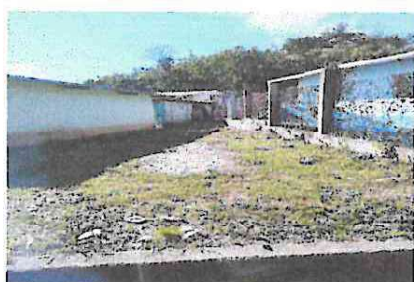
Foto 5: patio, mejoramiento de piso
