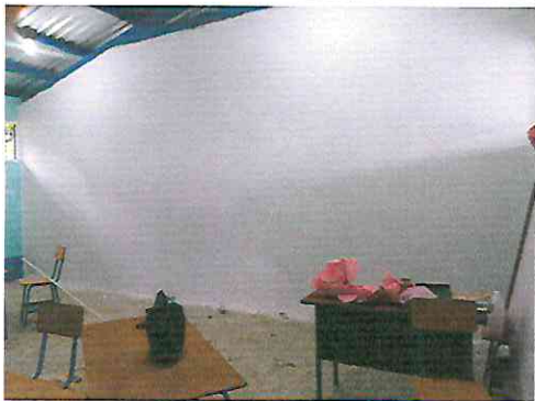
2.1 SUMINISTRO E INSTALACION DE REPELLO EN DIVISION DE PARED
