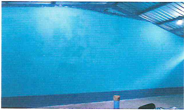
2.2 SUMINISTRO E INSTALACION DE PINTURA EN PARED
