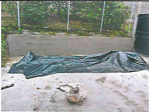
3.2 REPARACION DE MURO PERIMETRAL DE BLOCK
