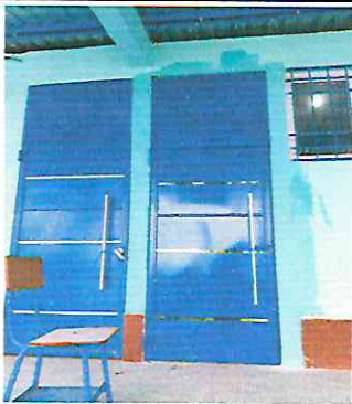
2.3 SUSTITUCION DE PUERTA EN MAL ESTADO POR PUERTA DE METAL DE 2.80 MTS DE ALT. X 1.1 MTS DE ANCHO
