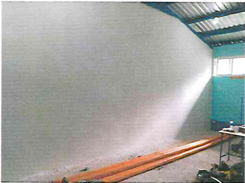
1.1 SUMINISTRO E INSTALACION DE REPELLO EN DIVISION DE PARED
