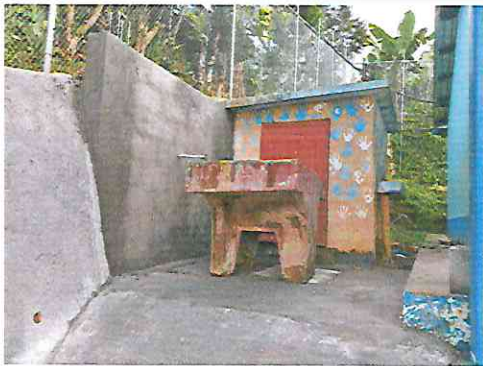
3.3 SUSTITUCION DE TUBERIA DE PVC LINEA PRINCIPAL DE AGUAS PLUVIALES
