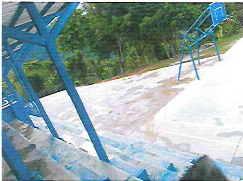
4.1 SUSTITUCION DE PISO DE TIERRA POR PISO DE CEMENTO
