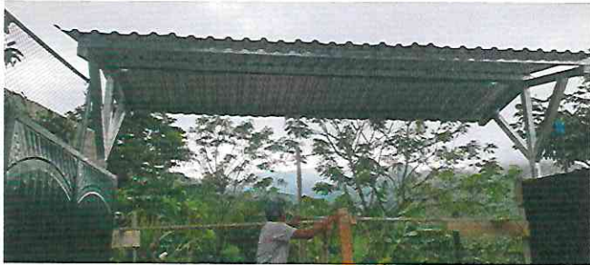
5.2 SUMINISTRO E INSTALACION DE LAMINA TROQUELADA ALUZINC CALIBRE 26 (SOBRE PORTON PARA EVITAR DETERIORO)
