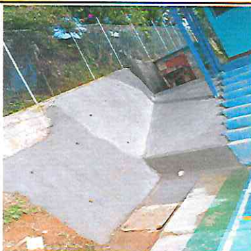
3.1 SUSTITUCION DE PISO DE TIERRA POR PISO DE CEMENTO ANEXO A CANCHA
