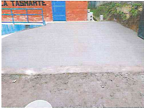
5.1 SUSTITUCION DE PISO DE TIERRA POR PISO DE CONCRETO
