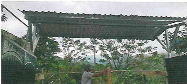
5.3 SUMINISTRO E INSTALACION DE ESTRUCTURA METALICA DE SOPORTE (SOBRE PORTON PARA EVITAR DETERIORO)
