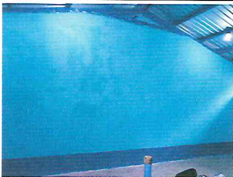
1.2 SUMINISTRO E INSTALACION DE PINTURA EN PARED
