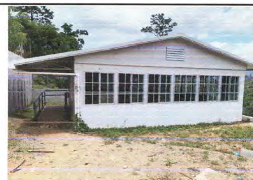
Foto 5: modulo prefabricado que necesita piso de concreto para evitar charcos alrededor
