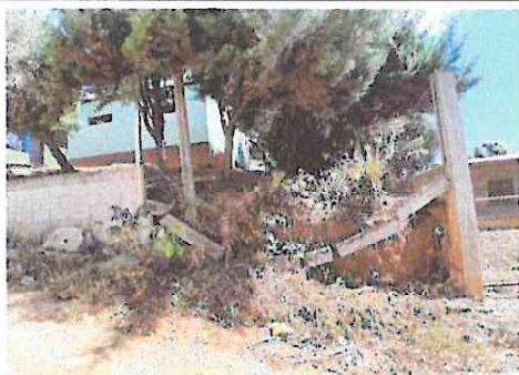
Foto 1: Reparación de muro perimetral de block pineado.
