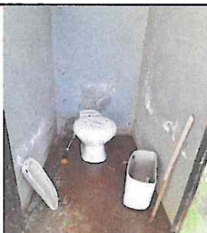
Foto 5: Sustrucción de inodoros.
