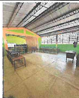
Foto 2: Reparación de sistema eléctrico externo e interno.
