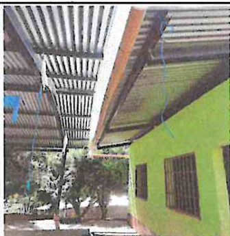
Foto 3: Sustrucción de canal de PVC.
