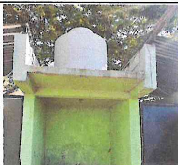
Foto 3: Sustitución de depósito de agua 1,100 lt.
