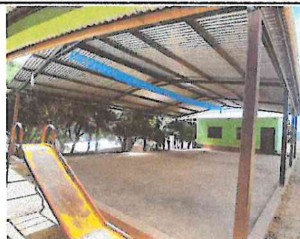
Foto 2: Mantenimiento a estructura de metal, pintura.
