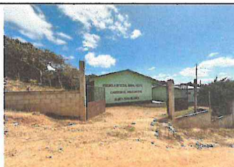
Foto 6: Mantenimiento a portones de metal.
