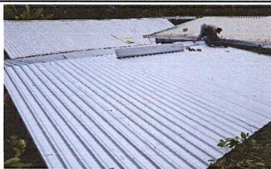
Foto 9: CUBIERTA DE LÁMINA ALUIN CALEBRE 26
