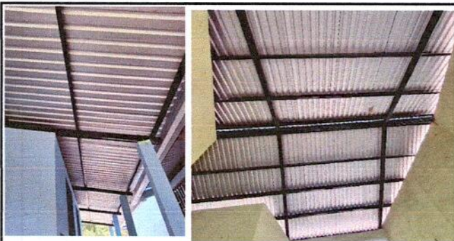
Foto 10: PINTURA EN ESTRUCTURA METÁLICA
