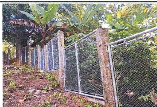
Foto 6: REPARACIÓN DE MURO PERIMETRAL DE BLOCK CON TUBO HG Y MALLA GALVANIZADA
