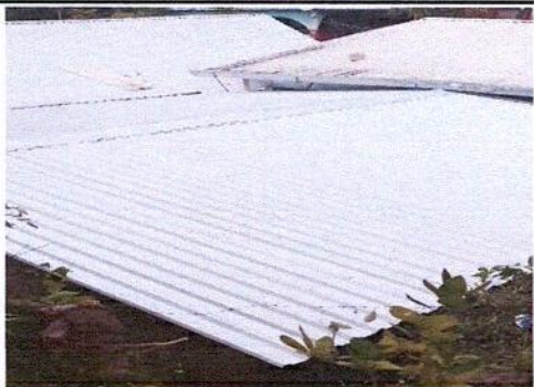
Foto 9: CUBIERTA DE LÁMINA ALUIN CALEBRE 26
