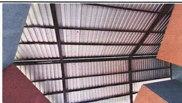
Foto 10: PINTURA EN ESTRUCTURA METÁLICA
