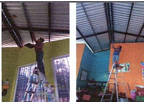
Foto 10: PINTURA EN ESTRUCTURA METÁLICA
