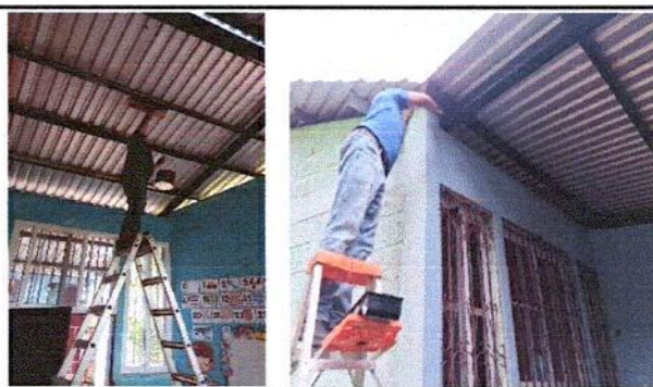
Foto 10: PINTURA EN ESTRUCTURA METÁLICA
