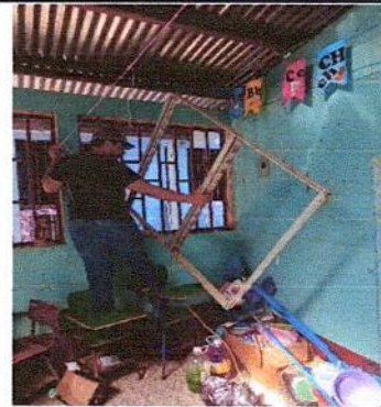
Foto 2: FABRICACIÓN DE VENTANA DE PVC
