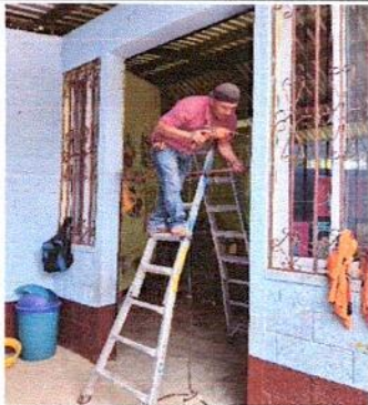
Foto 3: FABRICACIÓN DE VENTANA DE PVC
