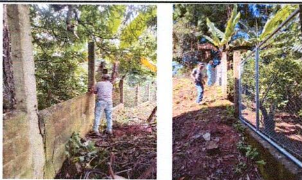
Foto 5: REPARACIÓN DE MURO PERIMETRAL DE BLOCK CON TUBO HG Y MALLA GALVANIZADA
