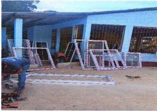
Foto 1: FABRICACIÓN DE VENTANA DE PVC
