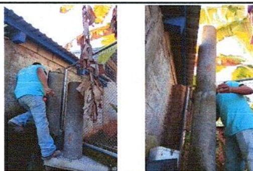
Foto 12: INSTALACIÓN DE CHIMENEA
