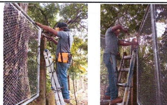
Foto 6: REPARACIÓN DE MURO PERIMETRAL DE BLOCK CON TUBO HG Y MALLA GALVANIZADA
