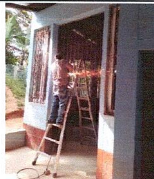
Foto 4: FABRICACIÓN DE VENTANA DE PVC
