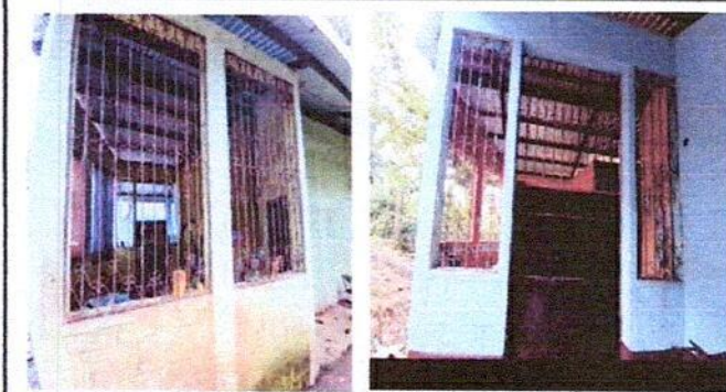
Foto1: FABRICACIÓN DE VENTANA DE PVC
