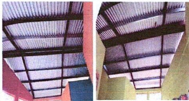
Foto 10: MANTENIMIENTO A ESTRUCTURA DE SOPORTE DE METAL
