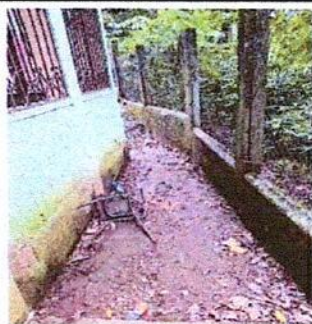
Foto 11: FUNDICIÓN DE CUBIERTA DE TORTA DE CEMENTO.
