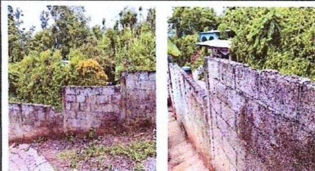
Foto7: REPARACIÓN DE MURO PERIMETRAL DE BLOCK CON TUBO HG Y MALLA GALVANIZADA
