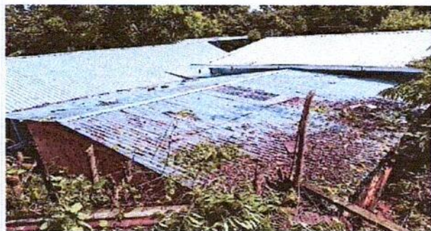
Foto 9: SUSTITUCIÓN DE LÁMINA, POR LÁMINA TROQUELADA ALUZING CALIBRE 26
