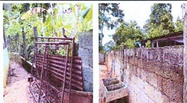
Foto 8: REPARACIÓN DE MURO PERIMETRAL DE BLOCK CON TUBO HG Y MALLA GALVANIZADA
