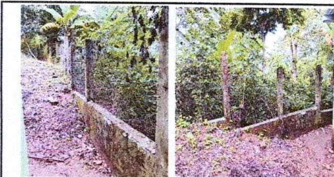
Foto 5: REPARACIÓN DE MURO PERIMETRAL DE BLOCK CON TUBO HG Y MALLA GALVANIZADA
