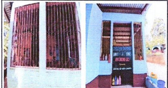
Foto 2: FABRICACIÓN DE VENTANA DE PVC
