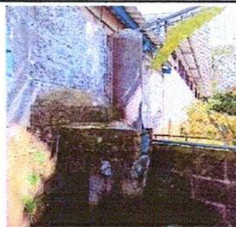
Foto 12: INSTALACIÓN DE CHIMENEA
