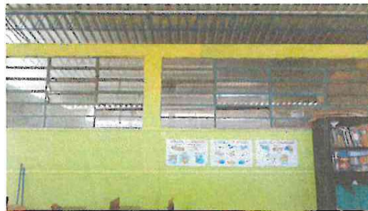
Foto 2: Sustitución de ventanas de vidrio a ventanas de pvc e instalación de balcones de metal.
