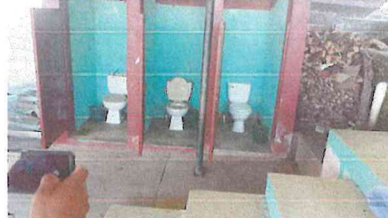
Foto 4: Instalación de Azulejo, sustitución de sanitarios.
