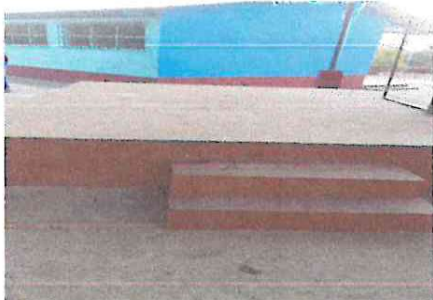
Foto 3: Sustitución de banqueta de concreto enfrente del aula a piso ceramico
