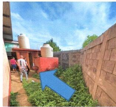
4.2 SUSTITUCION DE PISO DE TIERRA POR PISO DE CONCRETO
