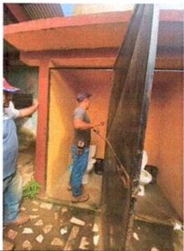
4.1 SUMINISTRO E INSTALACION DE PISO ANTIDESLIZANTE
