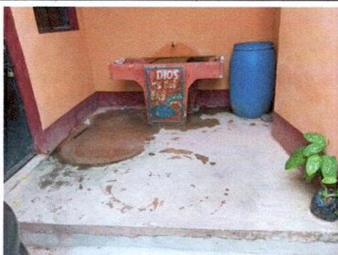
3.6 SUSTITUCION DE PILA EN MAL ESTADO POR PILA DE CONCRETO DE 2.70 MTS LARGO X 1.10 DE ANCHO X 0.85 ALTURA Y 7 MTS DE AZULEJO
