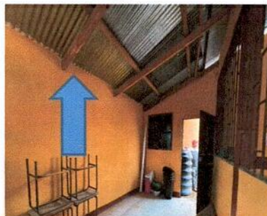
3.2 SUSTITUCION DE ESTRUCTURA DE MADERA POR ESTRUCTURA DE METAL COSTANERA
