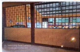
1.2 SELLADO DE VENTANA EN AULA ANEXA A COCINA POR CONTAMINACION VISUAL Y RESPIRATORIA (CUENTA CON VENTANAS FRENTE A AULA)
