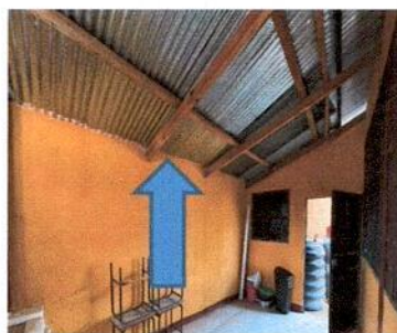
3.1 SUSTITUCION DE LAMINA EN MAL ESTADO POR LAMINA TROQUELADA ALUZINC CALIBRE 26
