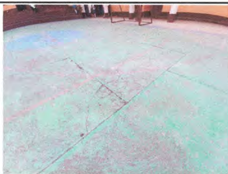
FOTO 3: LOSA DE PATIO (CANCHA)
