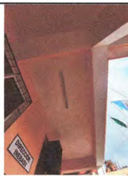
FOTO 4: REPARACION DE SISTEMA ELECTRICO
