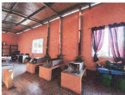
FOTO 5: Sustitución de planchas de metal 3 hornillas, Sustitución de chimeneas de metal
