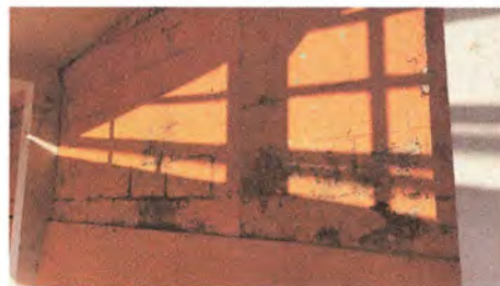
FOTO 2: PINTURA EN MUROS EXTERIOR E INTERIORES
