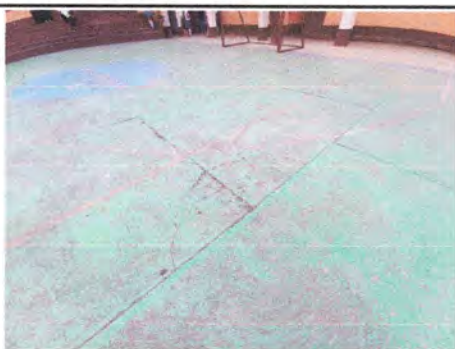
FOTO 3: LOSA DE PATIO (CANCHA)
