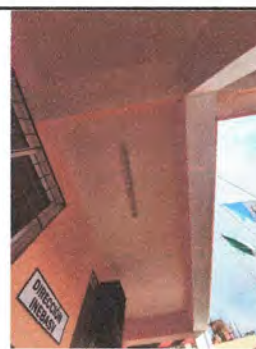
FOTO 4: REPARACION DE SISTEMA ELECTRICO
