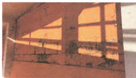
FOTO 2: PINTURA EN MUROS EXTERIOR E INTERIORES
