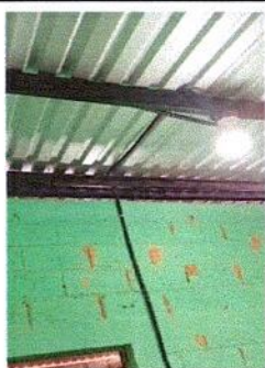
Foto 5: 3.2: INSTALACION DE CABLEADO CALIBRE 12 NEUTRO
