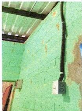
Foto 7: 3.4: INSTALACION DE APAGADORES SIMPLE
