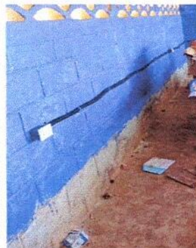
Foto 10 3.7: INSTALACION DE CAJAS RECTANGULARES
