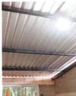
Foto1: 1.1: SUSTITUCION DE LAMINA POR LAMINA TROQUELADA ALUCIN CALIBRE 26
