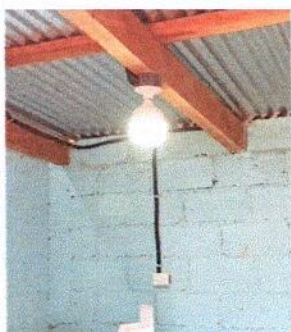
Foto 9 3.6: INSTALACION DE CAJAS OCTAGONALES
