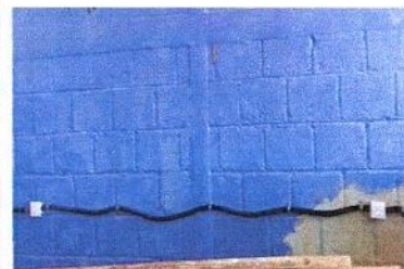
Foto 10 3.7: INSTALACION DE CAJAS RECTANGULARES
