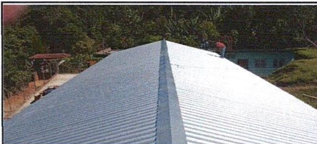
Foto 2: 1.2: SUSTITUCION DE CAPOTE DE METAL
