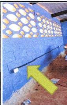
Foto 4: 3.1: INSTALACION DE CABLEADO CALIBRE 12 FASE
