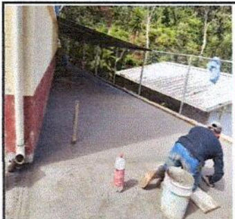
Foto 3: 2.1: SUSTITUCION DE PATIO DE TIERRA A TORTA DE CONCRETO
