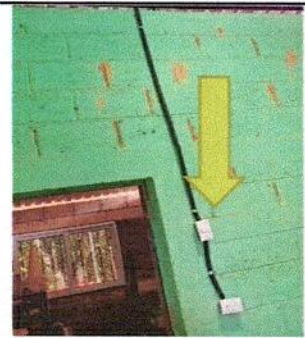
Foto 6: 3.3: INSTALACION DE TOMACORRIENTE DOBLE
