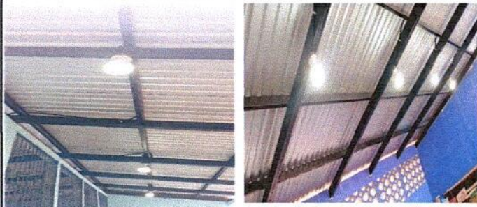
Foto 13: 3.10: INSTALACION DE LAMPARAS LED
