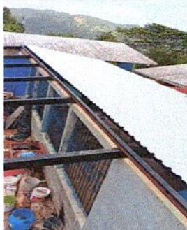
Foto1: 1.1: SUSTITUCION DE LAMINA POR LAMINA TROQUELADA ALUCIN CALIBRE 26
