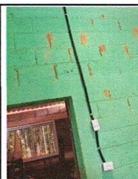
Foto 12 3.9: INSTALACION DE APAGADORES DOBLES
