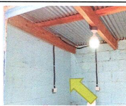
Foto 4: 3.1: INSTALACION DE CABLEADO CALIBRE 12 FASE
