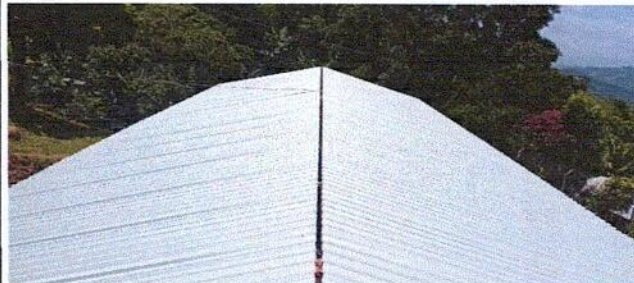
Foto 2: 1.2: SUSTITUCION DE CAPOTE DE METAL
