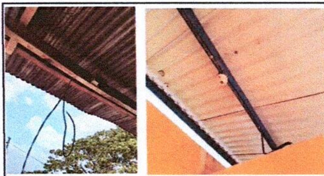
Foto 4: 3.1: INSTALACION DE CABLEADO CALIBRE 12 FASE
