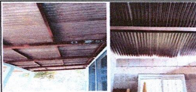
Foto 8: 3.5: INSTALACION DE PLAFONERAS
