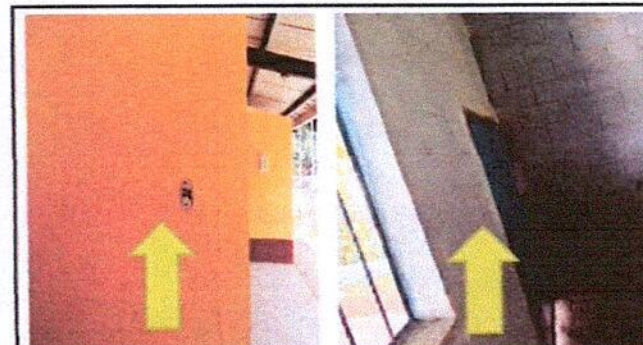
Foto 12 3.9: INSTALACION DE APAGADORES DOBLES
