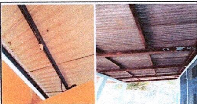
Foto 9 3.6: INSTALACION DE CAJAS OCTAGONALES
