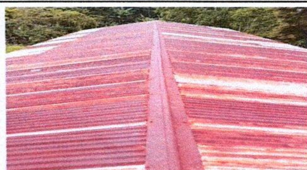
Foto 2: 1.2: SUSTITUCION DE CAPOTE DE METAL
