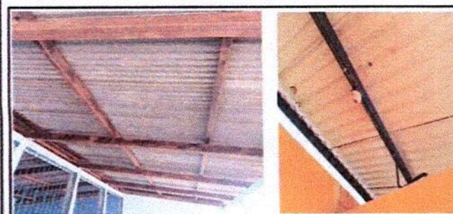
Foto 5: 3.2: INSTALACION DE CABLEADO CALIBRE 12 NEUTRO
