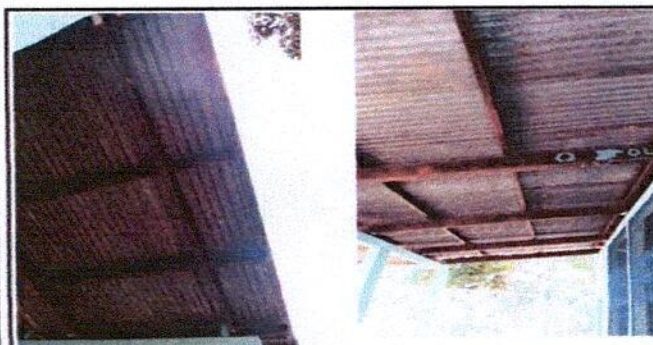
Foto 11 3.8: INSTALACION DE FLEXITUBO
