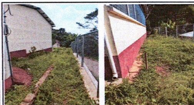
Foto 3: 2.1: SUSTITUCION DE PATIO DE TIERRA A TORTA DE CONCRETO
