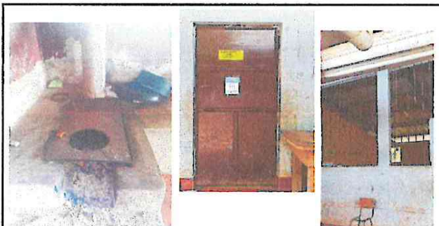
Foto 5: Reparación de base para estufa, sustitución de plancha para cocinar, mantenimiento lijat, limpiar y pintar puerta.
