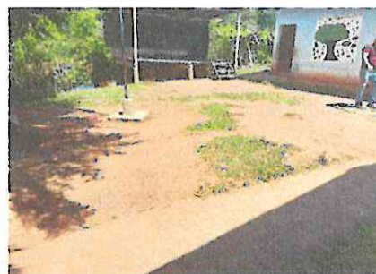
Foto 6: Instalación de planchas de concreto.
