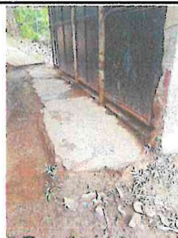
Foto 2: Fundir planca de cemento
