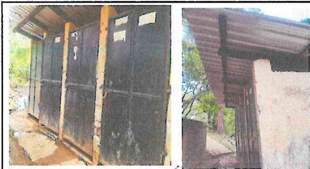
Foto 1: Sustitución de lamina por lamina froquelada aluzinc calibre 26, sustitución de portanted e inadera por metalica, mantenimiento lijat, limpiar, y pintar puertas.
