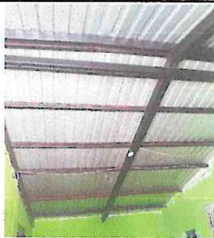
Foto 3: Instalación de 9 tomacorrientes, cableado y ductos, 9 apagadores y cableado y ductos, Instalación de cajas octagonales, plafoneras, cableado y ductos. Instalación de 7 bombillas de led de 50 watts.
