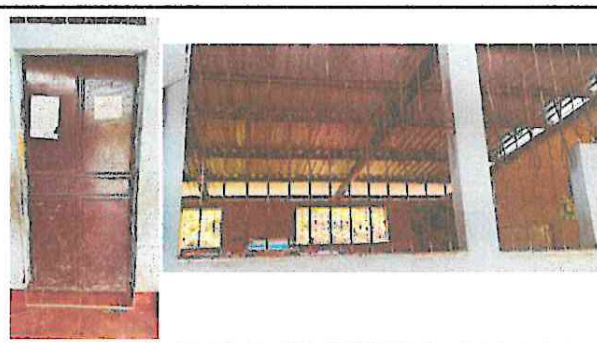
Foto 4: Mantenimiento lijat, limpiar y pintar puertas y balcones
