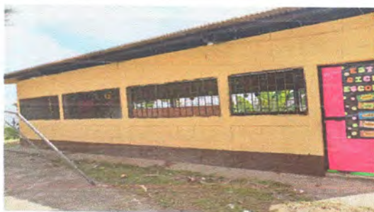
Foto 2.2.: Instalación de balcones de metal 1.05m x 2.55m.
