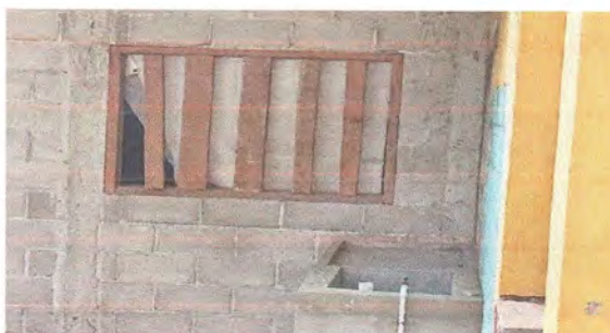
Foto 3.3: Instalación de balcones de metal de 1.10m x 1.50m
