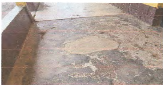
Foto 1.1: Reparación de base mas instalacion de piso cerámico nacional
