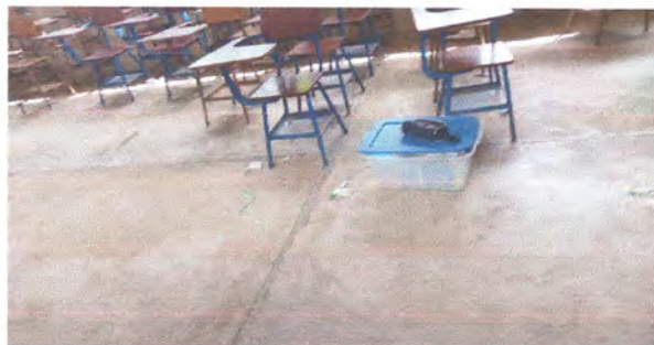
Foto 2.1: Instalación de piso cerámico nacional
