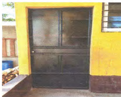
Foto 1.2: Mantenimiento de puertas de metal (lijado, cortado y pintado)
