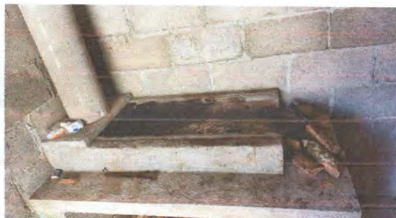
Foto 3.2: Mantenimiento de estufa rural (plancha, chimenea, ladrillo tayuyo).
