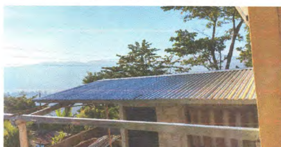
Foto 3.1: Sustitución de lamina por lamina troquelada alizink cal26.
