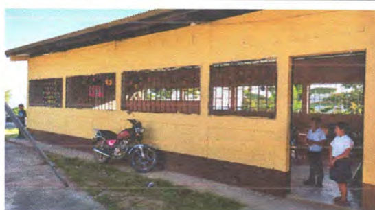
Foto 2.3: Instalación de balcones de metal 1.05m x 1.35m.
