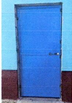
Foto1: SUSTITUCIÓN DE PUERTA DE MADERA POR METAL EN LA DIRECCIÓN (2 M * 1 M)
