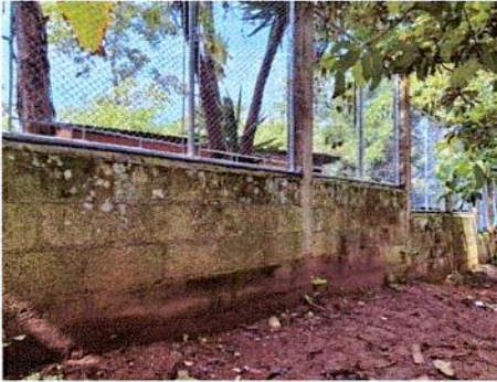
Foto 7: REPARACIÓN DE MURO PERIMETRAL DE BLOCK CON TUBO HG Y MALLA GALVANIZADA
