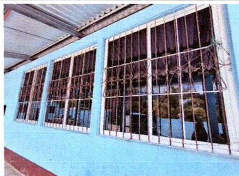
Foto 4: FABRICACIÓN DE VENTANA DE PVC
