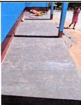
Foto 5: SUSTITUCIÓN DE TORTA DE CONCRETO EN EL CORREDOR
