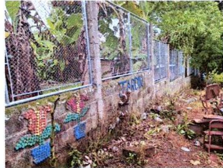
Foto 8: REPARACIÓN DE MURO PERIMETRAL DE BLOCK CON TUBO HG Y MALLA GALVANIZADA
