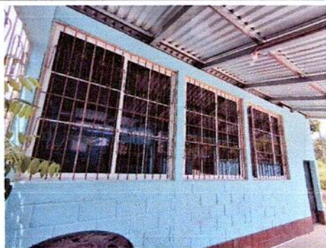
Foto 3: FABRICACIÓN DE VENTANA DE PVC
