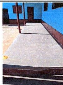
Foto 6: SUSTITUCIÓN DE TORTA DE CONCRETO EN EL CORREDOR
