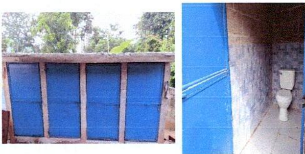
Foto 11: SUSTITUCIÓN DE SANITARIOS E INSTALACIÓN DE AZULEJOS.
