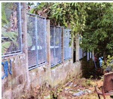
Foto 9: REPARACIÓN DE MURO PERIMETRAL DE BLOCK CON TUBO HG Y MALLA GALVANIZADA
