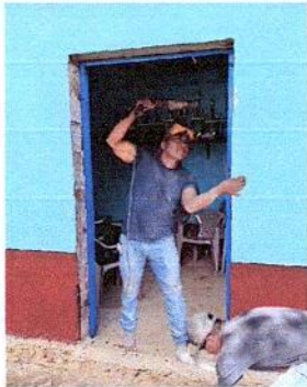
Foto1: SUSTITUCIÓN DE PUERTA DE MADERA POR METAL EN LA DIRECCIÓN (2 M * 1 M)
