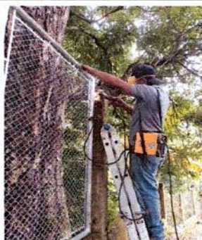
Foto7: REPARACIÓN DE MURO PERIMETRAL DE BLOCK CON TUBO HG Y MALLA GALVANIZADA
