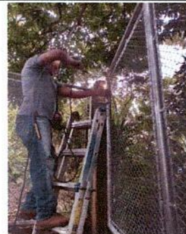
Foto 8: REPARACIÓN DE MURO PERIMETRAL DE BLOCK CON TUBO HG Y MALLA GALVANIZADA
