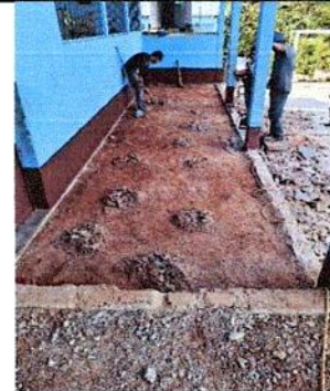
Foto 6: SUSTITUCIÓN DE TORTA DE CONCRETO EN EL CORREDOR
