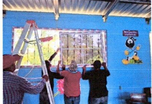
Foto 2: FABRICACIÓN DE VENTANA DE PVC
