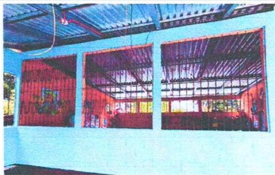
Foto 3: FABRICACIÓN DE VENTANA DE PVC
