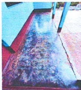
Foto 7: SUSTITUCIÓN DE TORTA DE CONCRETO EN EL CORREDOR
