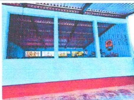
Foto 5: FABRICACIÓN DE VENTANA DE PVC
