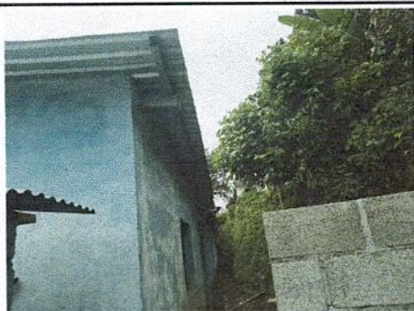
FOTO 5: Sustrucción de canal de pvc
