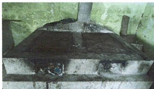
FOTO 7: Sustrución de plancha de metal 3 hornillas
