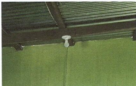
FOTO 9: Sustrución de focos ahorradores
