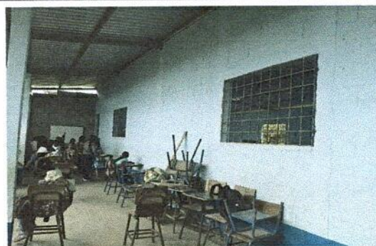
FOTO 4: Fabricación e instalación de ventana pvc-balcon de metal
