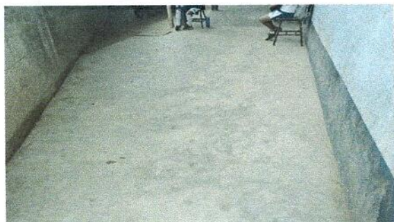
FOTO 3: Suministro e instalación piso cerámico
