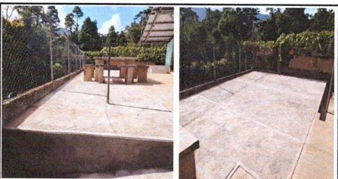
FOTO 5: 2.2 Sustitución de piso de tierra por entortado de cemento enfrente a la dirección, lado izquierdo.
