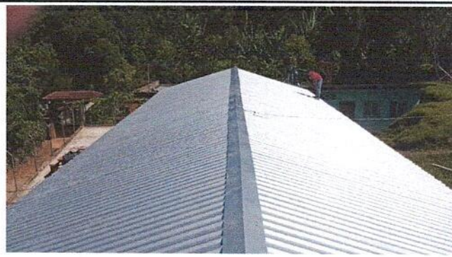
FOTO 2: 1.2 Sustitución de capote de metal de lamina para lamina troquelada.
