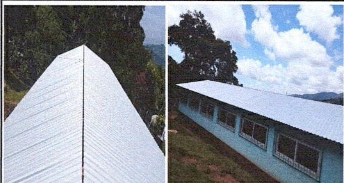
FOTO 1: 1.1 Sustitución de lámina, por lamina troquelada aluzinc calibre 26.
