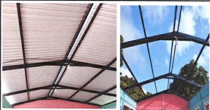
FOTO 3: 1.3 Mantenimiento de Costaneras (Lijado, cepillado, pintura).
