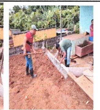
FOTO 5: 2.2 Sustitución de piso de tierra por entortado de cemento enfrente a la dirección, lado izquierdo.
