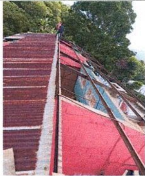
FOTO 1: 1.1 Sustitución de lámina, por lamina troquelada aluzinc calibre 26.
