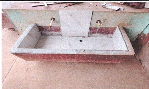
FOTO 7: 4.1 Suministro e instalación de azulejo en lavamanos de cemento ya existente.
