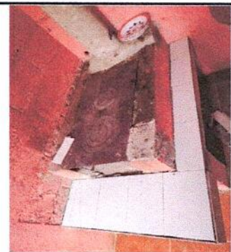
FOTO 6: 3.1 Suministro e instalación de azulejo en planchas ya existente en cocina.
