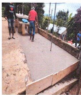
FOTO 4: 2.1 Sustitución de piso de tierra por entortado de cemento enfrente de aula lado derecho.
