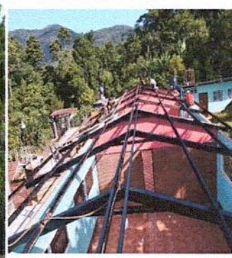
FOTO 3: 1.3 Mantenimiento de Costaneras (Lijado, cepillado, pintura).
