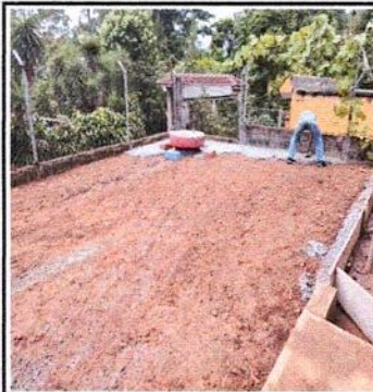
FOTO 5: 2.2 Sustitución de piso de tierra por entortado de cemento enfrente a la dirección, lado izquierdo.
