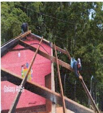
FOTO 3: 1.3 Mantenimiento de Costaneras (Lijado, cepillado, pintura).
