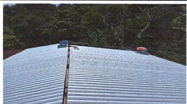
FOTO 2: 1.2 Sustitución de capote de metal de lamina para lamina troquelada.
