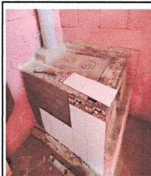
FOTO 6: 3.1 Suministro e instalación de azulejo en planchas ya existente en cocina.
