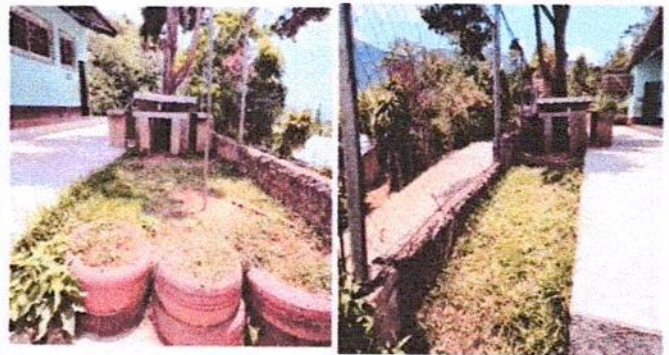
FOTO 4: 2.1 Sustitución de piso de tierra por entortado de cemento enfrente de aula lado derecho.
