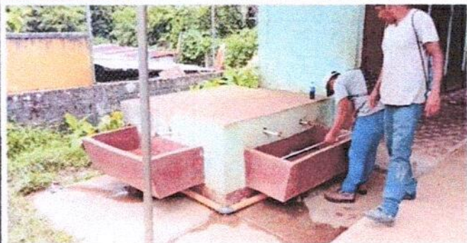
FOTO 7: 4.1 Suministro e instalación de azulejo en lavamanos de cemento ya existente.
