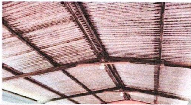
FOTO 3: 1.3 Mantenimiento de Costaneras (Lijado, cepillado, pintura).
