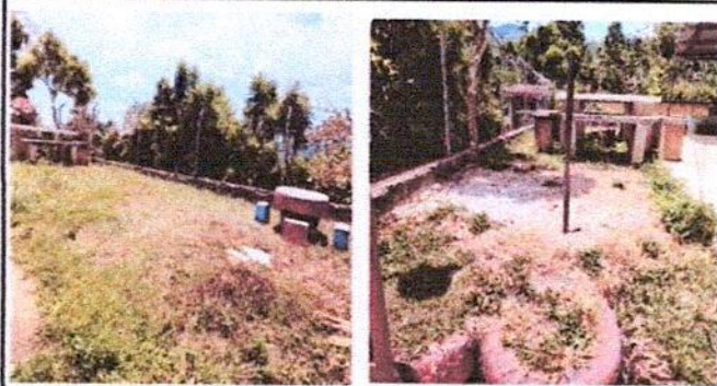
FOTO 5: 2.2 Sustitución de piso de tierra por entortado de cemento enfrente a la dirección, lado izquierdo.
