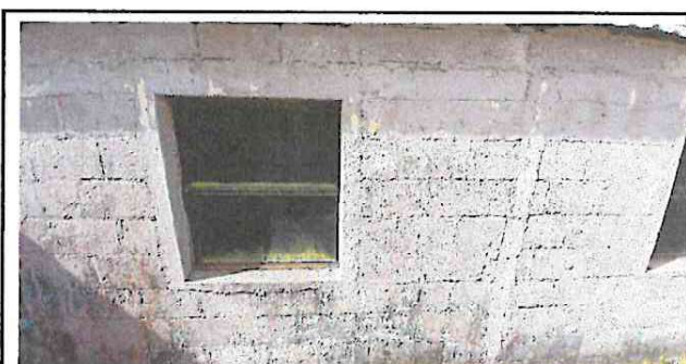
Foto 6: sustitución de valcones
