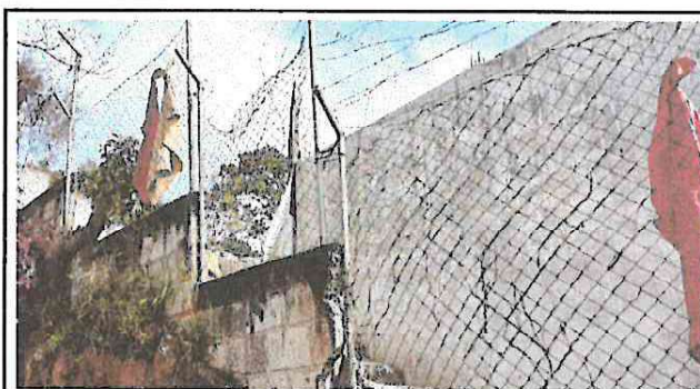
Foto 4: Reparación de muro perimetral pvc
