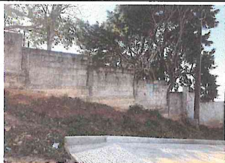
Foto 1: Reparación de muro perimetral de block.
