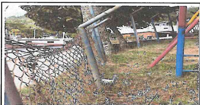
Foto 5: Reparación de tubo hg y malla galvanizada
