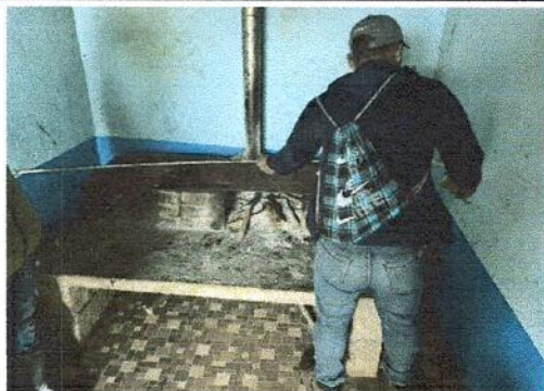
Foto 1. SUMINISTRO E INSTALACIÓN DE ESTUFA RURAL (COMPLETA) BASE, CHIMINEA, Y PLANCHA
