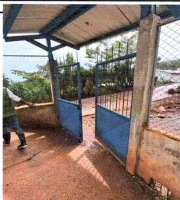
FOTO 15: MANTENIMIENTO A ESTRUCTURA (LIJADO, CEPILLADO Y APLICACIÓN DE PINTURA) EN PORTÓN
