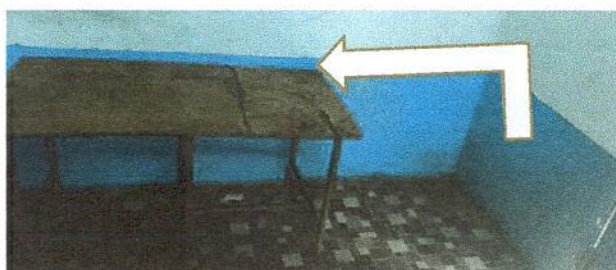
FOTO 2: SUMINISTRO E INSTALACIÓN DE TABLON DE 5.10 MTS DE LARGO * 85 CM DE ANCHO * 90 DE ALTO DE CONCRETO
