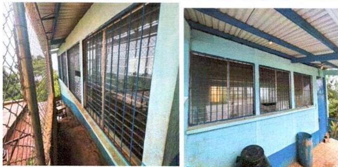
FOTO 13: MANTENIMIENTO A ESTRUCTURA (LIJADO, CEPILLADO Y APLICACIÓN DE PINTURA) EN BALCÓN
