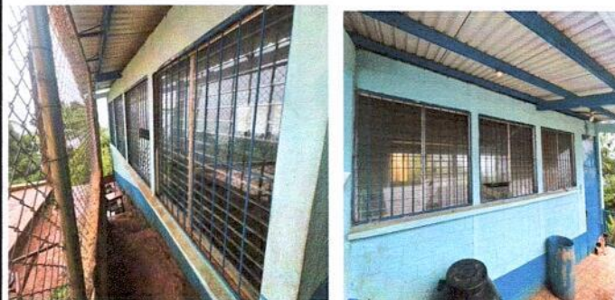
FOTO 14: SUMINISTRO E INSTALACIÓN DE DE VENTANA PVC
