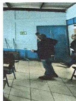
FOTO 6: MANTENIMIENTO A ESTRUCTURA (LIJADO, CEPILLADO Y APLICACIÓN DE PINTURA) ENPUERTA
