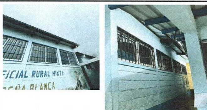
FOTO 5: PINTURA EN MUROS EXTERIORES E INTERIORES
