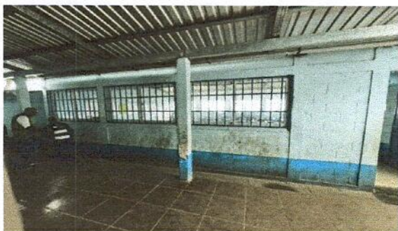
FOTO 7: MANTENIMIENTO A ESTRUCTURA (LIJADO, CEPILLADO Y APLICACIÓN DE PINTURA) EN BALCÓN
