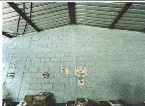
FOTO 8: APLICACIÓN DE PINTURA EN MUROS EXTERIORES E INTERIORES
