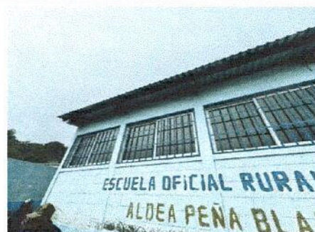
FOTO 4: SUMINISTRO E INSTALACIÓN DE CANAL DE METAL CON BAJADA DE AGUA
