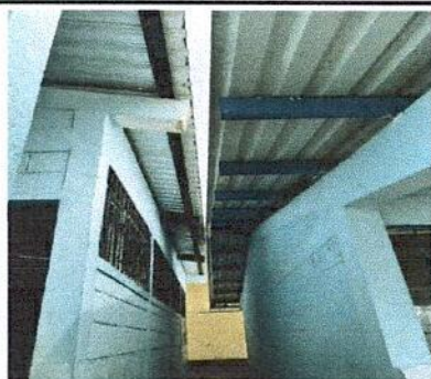
FOTO 11: SUMINISTRO E INSTALACIÓN DE CANAL DE METAL CON BAJADA DE AGUA
