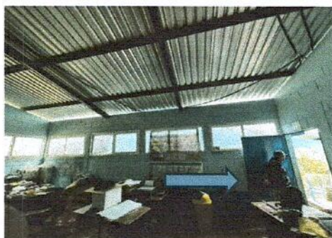
FOTO 9: MANTENIMIENTO A ESTRUCTURA (LIJADO, CEPILLADO Y APLICACIÓN DE PINTURA) EN PUERTA
