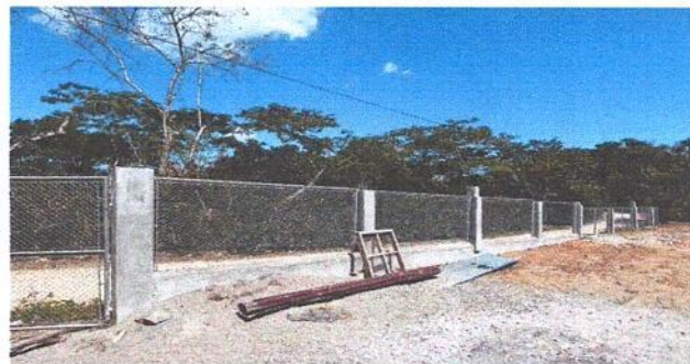
Foto 2: parte inferior donde se visualiza como quedo maya, cernido y repello.
