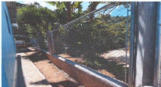
Foto1: Se muestra parte donde la maya fue colocada.
