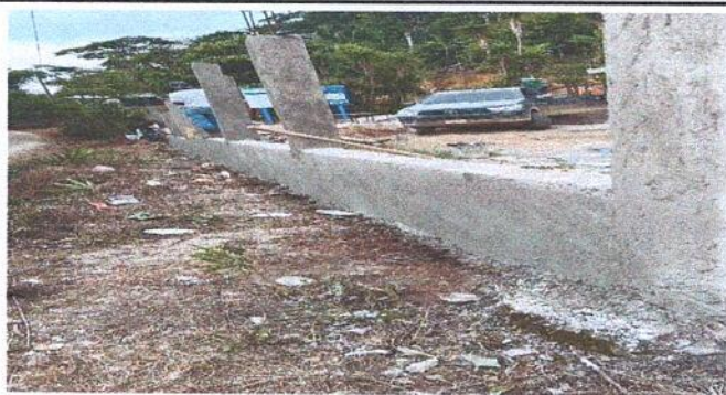
Foto 3: Se muestra la parte superior con cernido y repellido.
