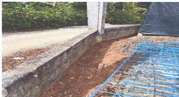
Foto1: En la fotografía se muestra donde fueron limpiando el area.
