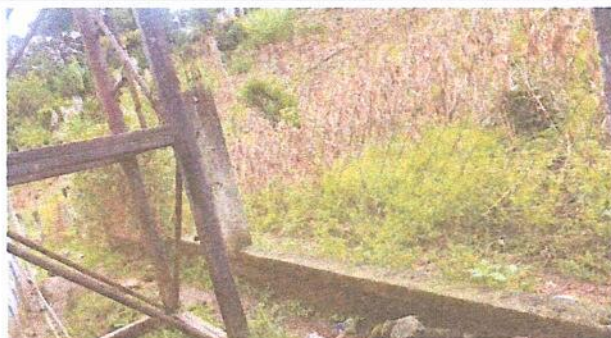
Foto 3: REPARACION DE MURO PERIMETRAL DE BLOCK CON TUBO HG Y MAYA GALVANIZADA AHUJERO 2X2
