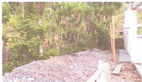
Foto 5: REPARACION DE MURO PERIMETRAL DE BLOCK CON TUBO HG Y MAYA GALVANIZADA AHUJERO 2X2
