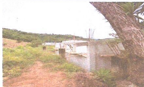
Foto 4: REPARACION DE MURO PERIMETRAL DE BLOCK CON TUBO HG Y MAYA GALVANIZADA AHUJERO 2X2
