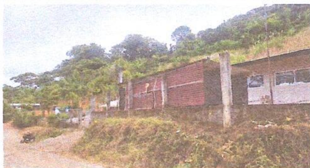
Foto 1: MEJORAMIENTO CON REPELLO EN MURO. MEJORAMIENTO CON CERNIDO EN MURO. REPARACION DE MURO PERIMETRAL DE BLOCK CON TUBO HG Y MAYA GALVANIZADA AHUJERO 2X2
