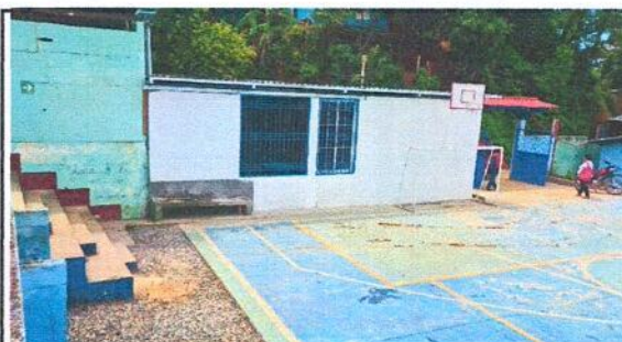
Foto 4: SUSTITUCIÓN DE VENTANA DE MALLA POR VALCÓN
