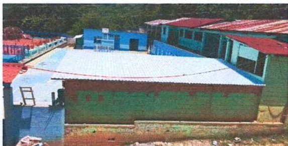
Foto 1: SUSTITUCIÓN DE LÁMINA TROQUELADA ALUZINC CALIBRE 26
