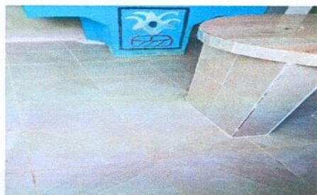
Foto 5: INSTALACIÓN DE TORTA DE CEMENTO Y PISO CERÁMICO
