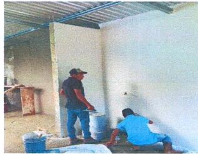
Foto 8: REPELLO Y CERNIDO DE PAREDES
