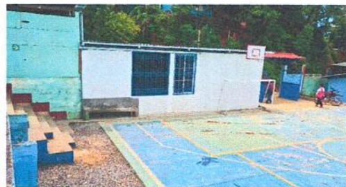
Foto 10: LEVANTADO DE CUATRO HILADAS DE BLOCK PARA INSTALACIÓN DE TECHO
