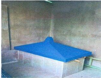
Foto 7 : SUSTITUCIÓN DE PLANCHA DE METAL.
