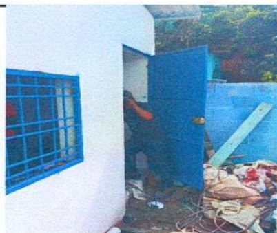
Foto 3: SUSTITUCIÓN DE PUERTA DE METAL
