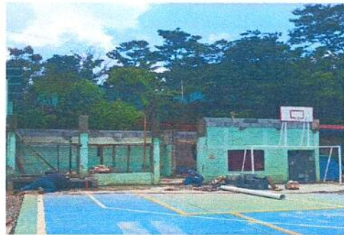
Foto 4: SUSTITUCIÓN DE VENTANA DE MALLA POR VALCÓN
