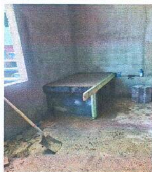
Foto 7 : SUSTITUCIÓN DE PLANCHA DE METAL.
