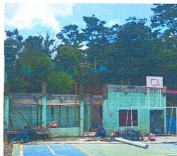
Foto 10: LEVANTADO DE CUATRO HILADAS DE BLOCK PARA INSTALACIÓN DE TECHO
