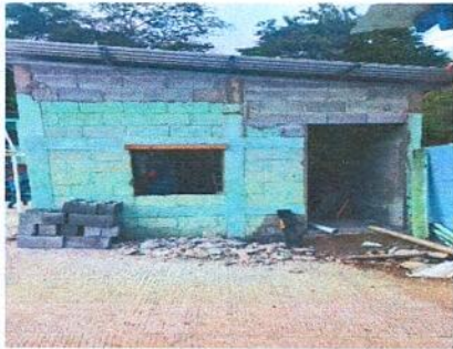
Foto 3: SUSTITUCIÓN DE PUERTA DE METAL
