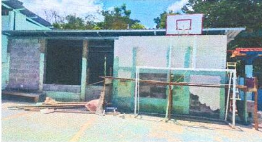
Foto 1: SUSTITUCIÓN DE LÁMINA TROQUELADA ALUZINC CALIBRE 26
