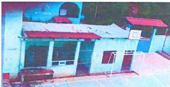
Foto 1: SUSTITUCIÓN DE LÁMINA TROQUELADA ALUZINC CALIBRE 26
