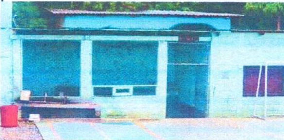
Foto 4: SUSTITUCIÓN DE VENTANA DE MALLA POR VACÓN
