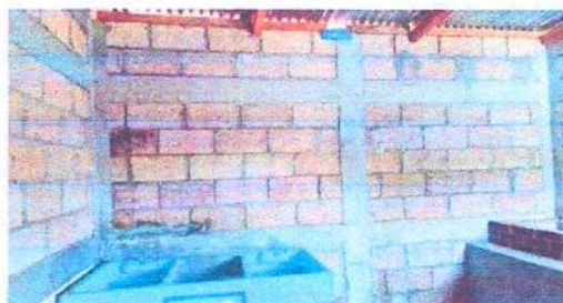
Foto 6: ELEABORACIÓN DE GABINETE DE CONCRETO E INSTALACIÓN DE AZULEJO
