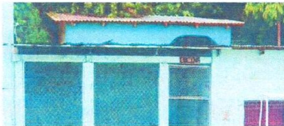
Foto 10: LEVANTADO DE CUATRO HILADAS DE BLOCK PARA INSTALACIÓN DE TECHO
