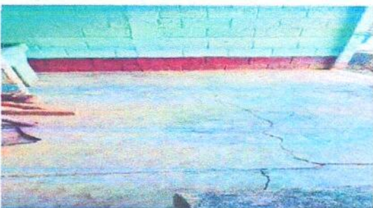
Foto 5: INSTALACIÓN DE TORTA DE CEMETO Y PISO CERÁMICO
