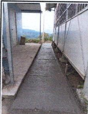
Foto 3: Sustitucion torta de concreto
