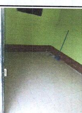
Foto 6: Sustitución de piso de granito por piso cerámico, Sellado de grietas y fisuras en paredes
