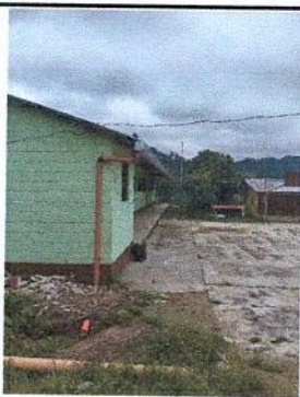
Foto 5: Sustitución de canal de aluzinc de 6 m, Sustitución de canal de aluzinc de 3 m, Instalación de bocanudo aluzinc de agua pluvial, Instalación de tapaderas para canales aluzinc, Instalación de uniones de aluzinc, Instalación de soportes para canales aluzinc, Instalación de bajadas de agua pluvial de pvc 3", Instalación de soportes de costaneras para canales aluzinc
