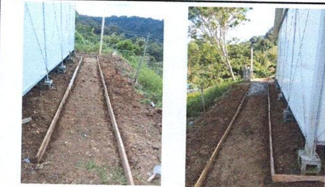
Foto 3: Sustitución torta de concreto
