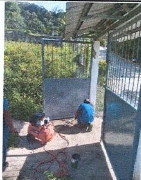
Foto 7: Mantenimiento a portón de metal
