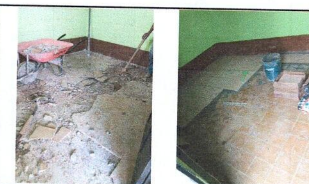
Foto 6: Sustitución de piso de granito por piso cerámico, Sellado de grietas y fisuras en paredes
