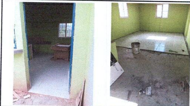
Foto1: Sustitución de piso de cemento por piso cerámico, Instalación de azulejo en gabinete de cocina y base de polletón
