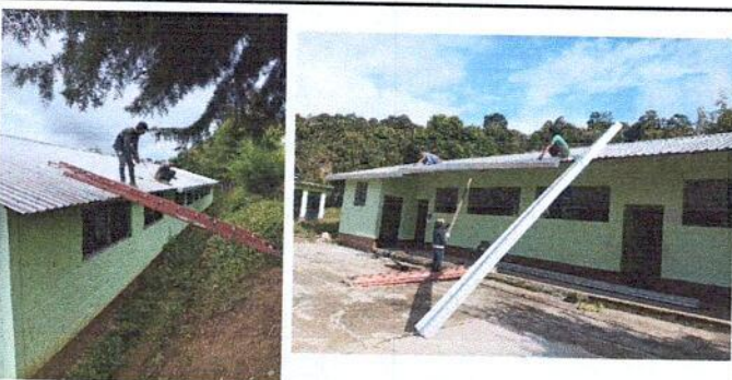
Foto 5: Sustitución de canal de aluzinc de 6 m, Sustitución de canal de aluzinc de 3 m, Instalación de bocanudo aluzinc de agua pluvial, Instalación de tapaderas para canales aluzinc, Instalación de uniones de aluzinc, Instalación de soportes para canales aluzinc, Instalación de bajadas de agua pluvial de pvc 3", Instalación de soportes de costaneras para canales aluzinc
