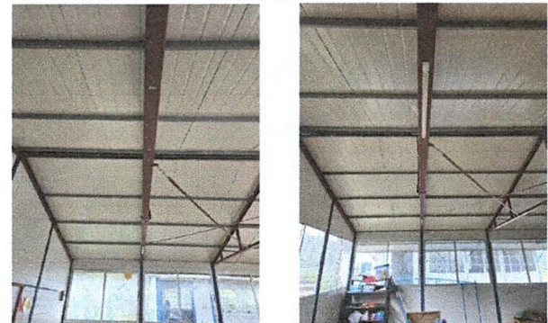
Foto 4: Sustitución lámparas tipo LED, Reparación de cableado eléctrico, Sustitución tomacorrientes dobles, Sustitución de interruptores dobles, Sustitución de flípones, Sustitución de ductos eléctricos más accesorios
