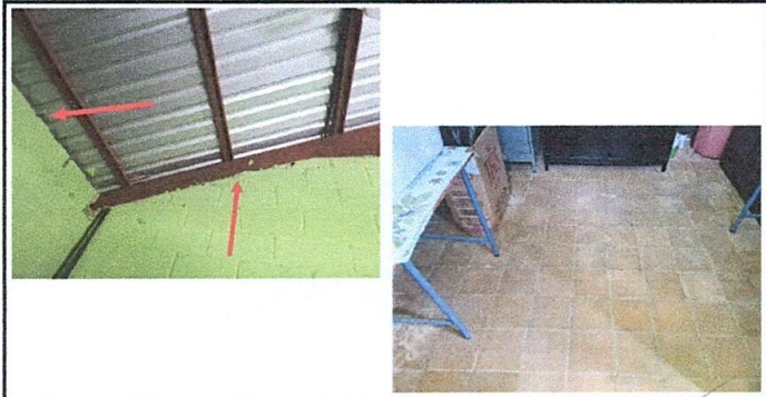
Foto 6: Sustitución de piso de granito por piso cerámico, Sellado de grietas y fisuras en paredes
