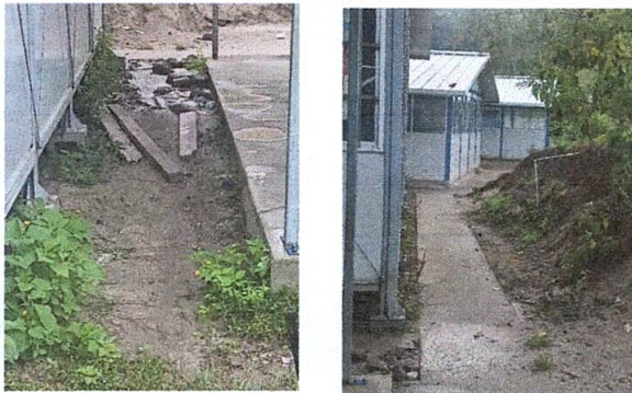
Foto 3: Sustitución torta de concreto
