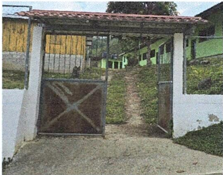
Foto 7: Mantenimiento a portón de metal
