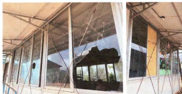
Foto 2: Módulos 2: sustitución de tres ventanas de vidrio por que se encuentran quebradas cada ventana mide 1.85x .85 haciendo un total de 4.7175 metros cuadrados por las 3 en total.
