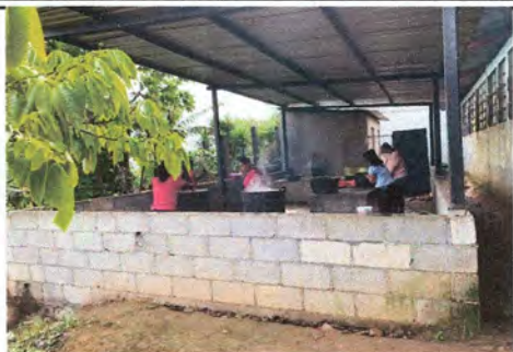
Foto 1: Módulo de cocina sustitución de 30 m2 con malla de metal incluyendo mano de obra y transportación del material.
