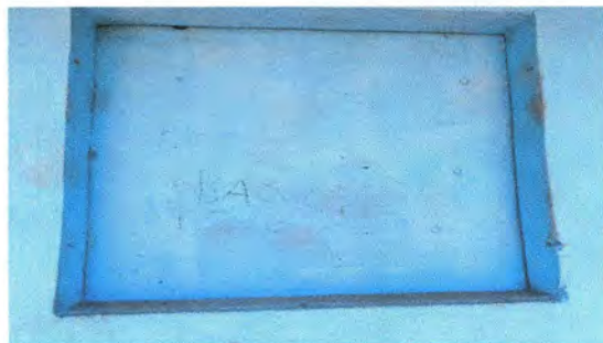
Foto 8: Módulo 3: colocación de balcon incluido en el presupuesto.
