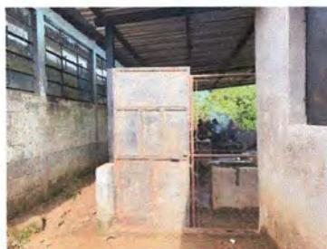
Foto 4: Modulo de cocina sustitución de portón de metal en la cocina de
