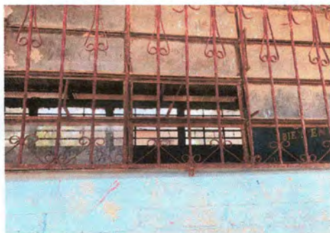
foto 9: Módulo 1 sustitucion de balcones rotos y deteriorado
