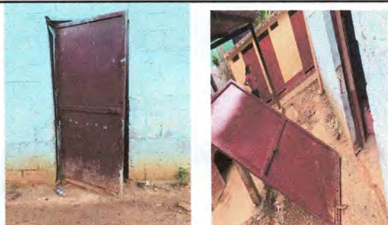
Foto 5: Módulo de aulas: sustitucion de puerta de bodega se encuentra en mal estado
