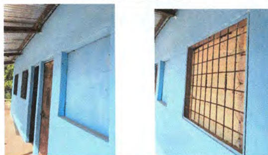
Foto 6: Módulo de aulas: sustitución de balcones por que se encuentran quebrados y colocacion de balcón donde no hay incluyendo el traslado del material y mano de obra de instalación.
