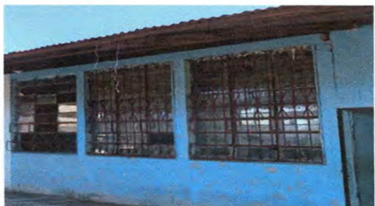
Foto 7: módulo de aulas 1: se sustituirá ventanas por balcones y en el presupuesto se incluye mano de obra y traslado de materiales al establecimiento. Total de metros cuadrados de balcones es de 77.88 m2
