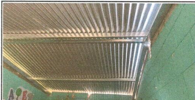
Foto 5: Estructura de metal galvanizado, cambio de lamina
