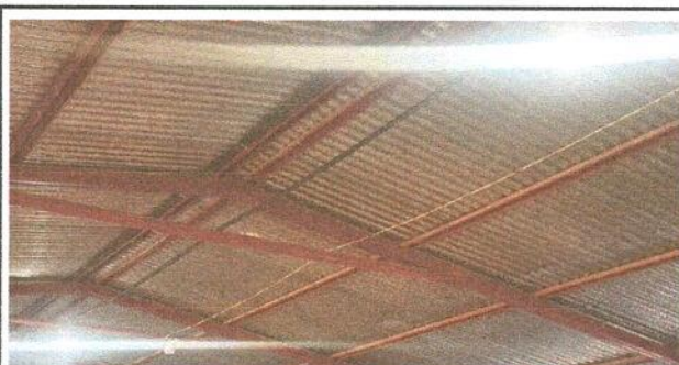
Foto 6: Instalación de sistema electrico de iluminación
